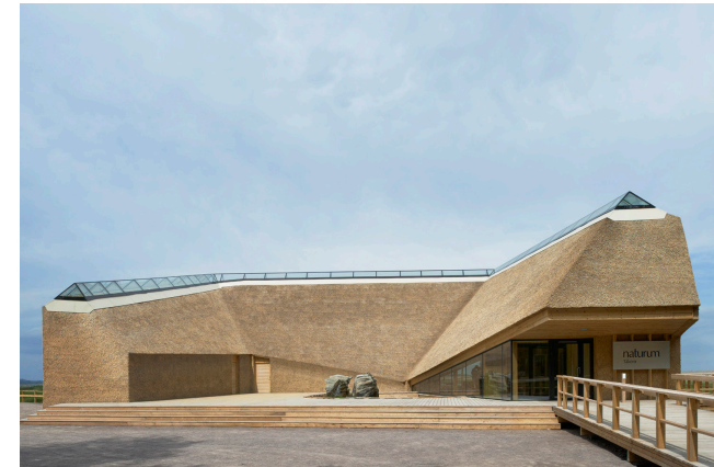
Naturum Tåkern ritad av Wingårdhs. Den vass beklädda monoliten skapar en varierade rumssekvens av öppenhet och slutenhet mellan strandskogarna av gran, tall och oändliga vatten- och vasstäckt mark. Naturum Tåkern är ytterligare en Naturum-byggnad som utmanar svensk arkitektur och utvecklar traditionen av att bygga med vass.
