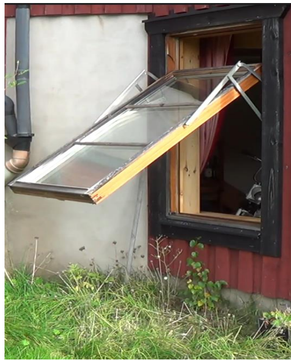
Figur 10. Fönster nummer 4, utsida
