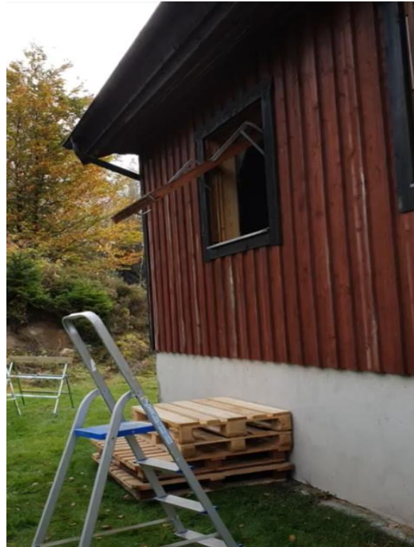
Figur 12. Fönster nummer 5, utsida
