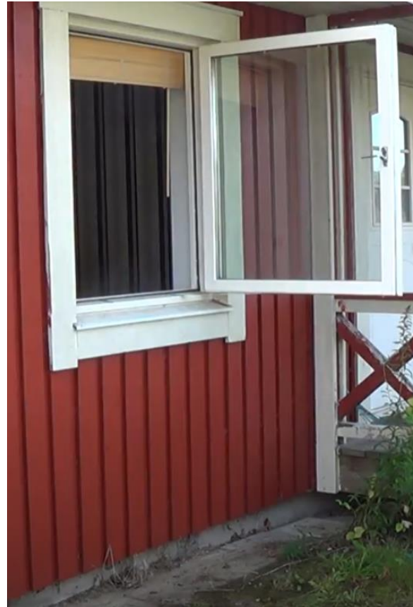
Figur 4. Fönster nummer 1, utsida
