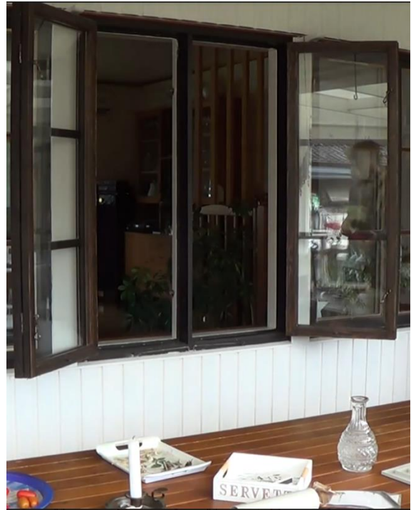
Figur 8. Fönster nummer 3, utsida
