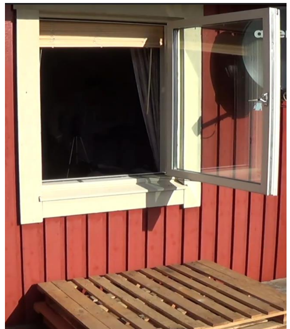
Figur 6. Fönster nummer 2, utsida
