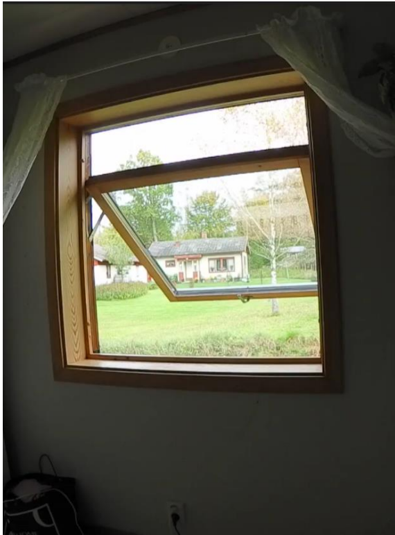
Figur 11. Fönster nummer 5, insida
