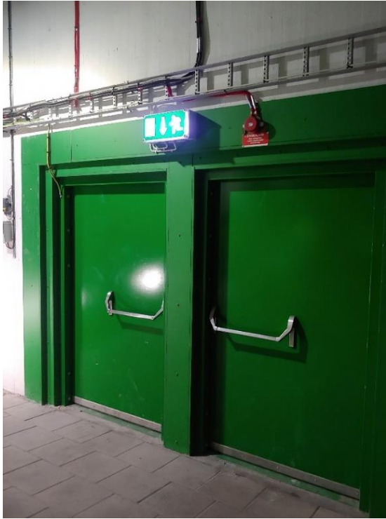
Figur 14 Foto från slussen som ligger mellan tunnelröret och servicetunneln i Citybanan (Bild av Linnea Mauritz)
