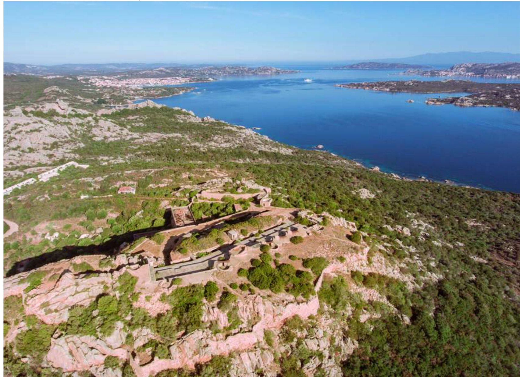
8.1 Flygbild av Batteria Capo d'Orso
