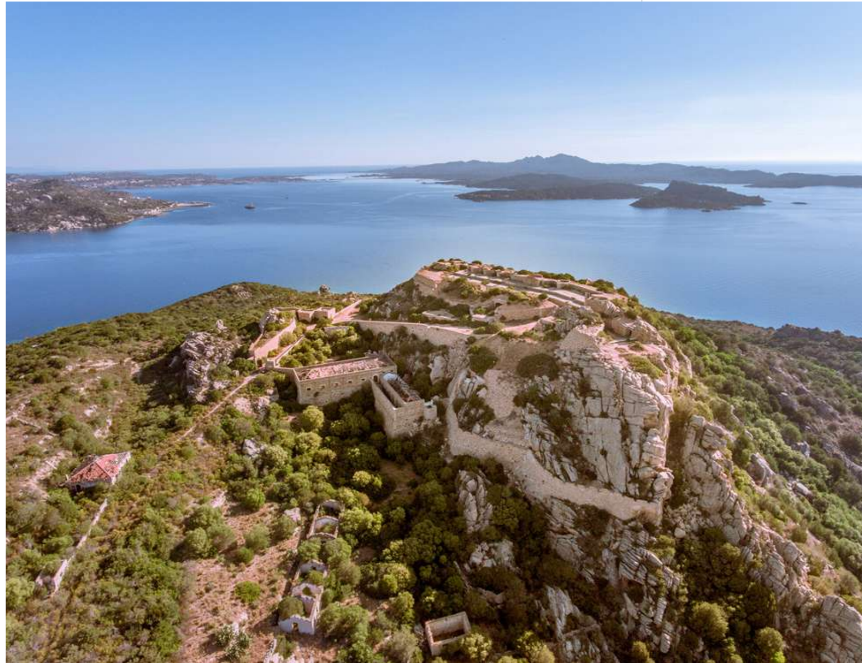
7.1 Flygbild av Batteria Capo d'Orso
