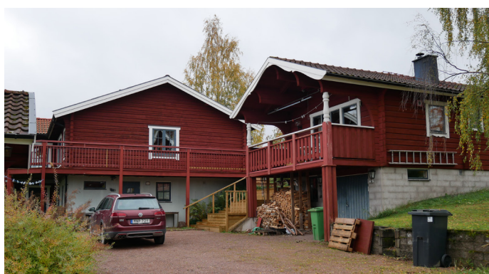
Gård med två hus i souterräng väster om tomten.
