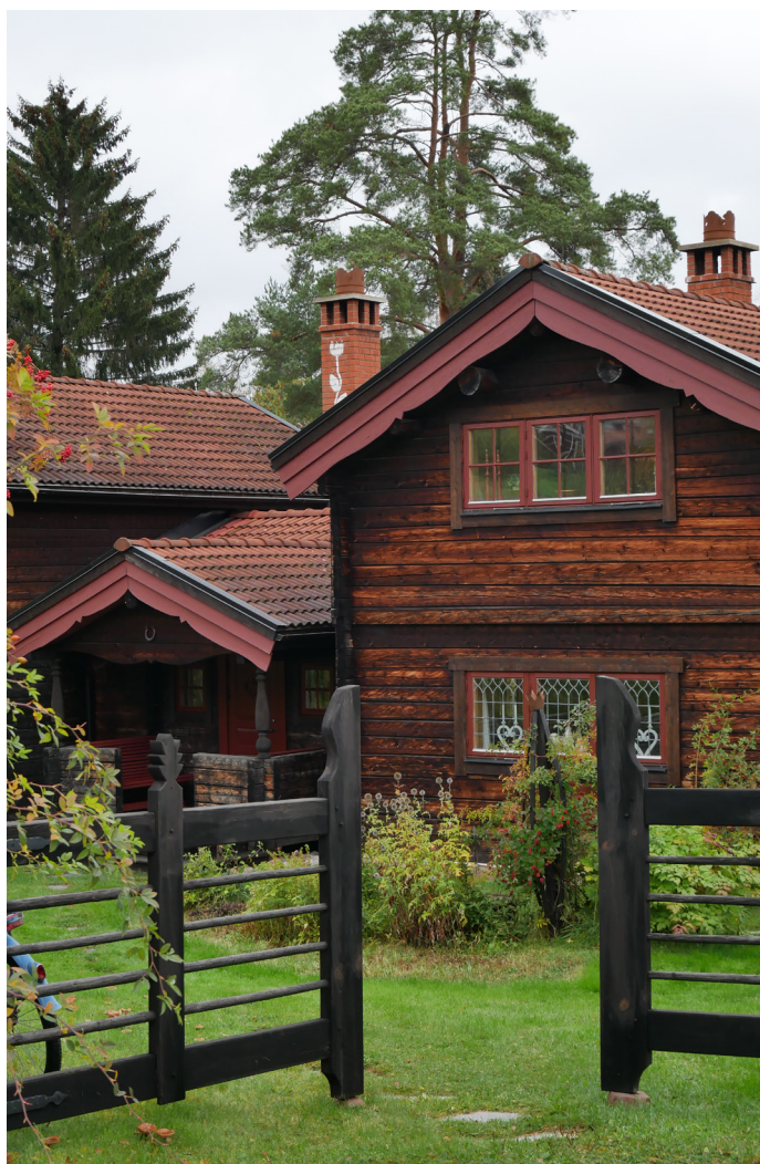
Nyare timmerhus i dalaromantisk stil med inslag som blyspröjsade fönster, kronskorstenar, profilerade vindskivor och balusterdockor.
