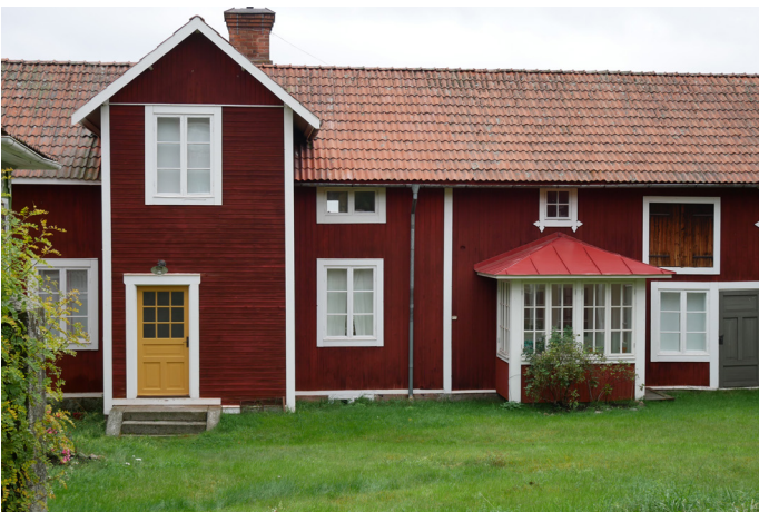
Fjärsmansgården är en æbyns välbevarade gårdar som har korsplanshus, typiskt för Alvik och en kringbyggd karaktär (Ärnäck 2021, s. 19). Entrén till bostadshuset har en anmärkningsvärd glasveranda med gröna och vita snickeridetaljer.
