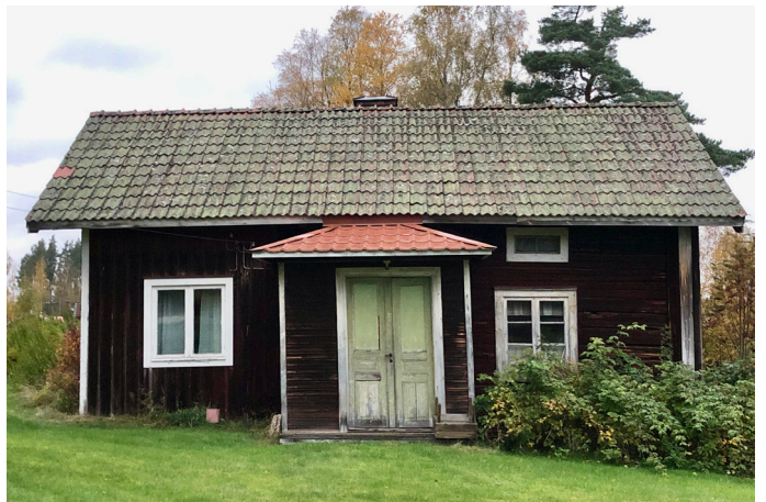
Mindre korsplanshus med fasad i både timmer och träpanel samt pardörr i en sober grön kulör.
