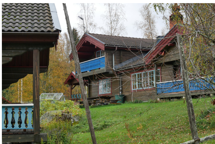
Gård i nordöstra delen avbyn, uppförd i dalaromantisk stil. Den pariserblå färgen återkommer på bl.a. dörrar, fönster och färestukvistar i byn, här i en något avvikande, möjligtvis något för stark kulör.
