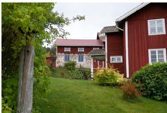
Ladugårdslängan i nedre bild är byggd med en s.k. gjutmursdel. I Leksand finns det flera specialister som kunde bygga med denna teknik. (Ärnäck 2021, s. 9)
