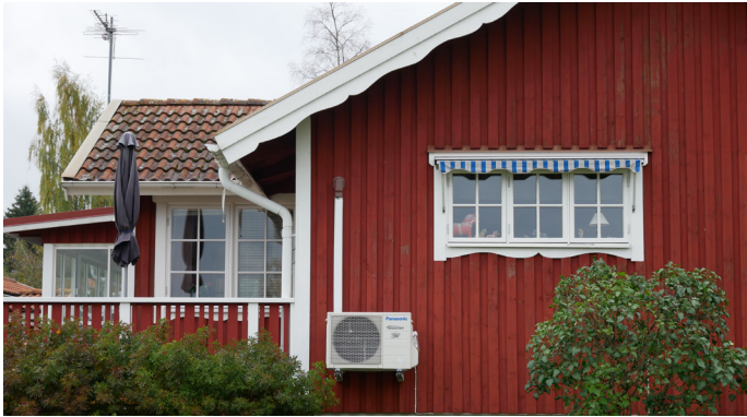
Gävelfasader på husen norr om tomten, varav ett som har källarplan.
