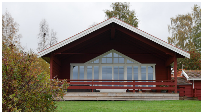
Huset söder om tomten med glasat gavelparti mot utsikten i norr.
