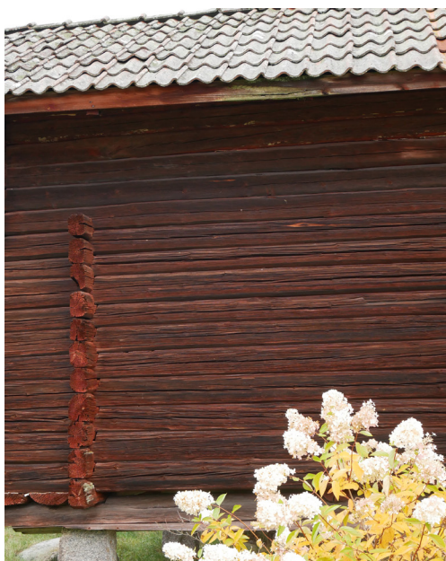
Rödmålad äldre timmervägg
