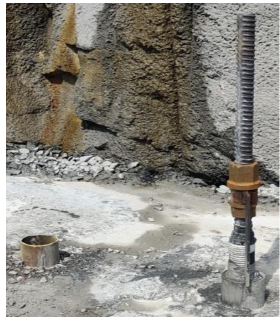
Figur 2. Passiv förankring som är förankrad i berget i Varbergstunnelprojektet.
