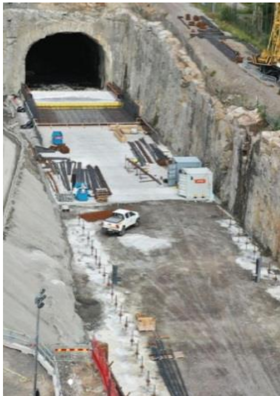
Figur 1. Bild på plats där betongtråg kommer uppföras i södra tunnelmynningen i Varbergstunnelprojektet.
