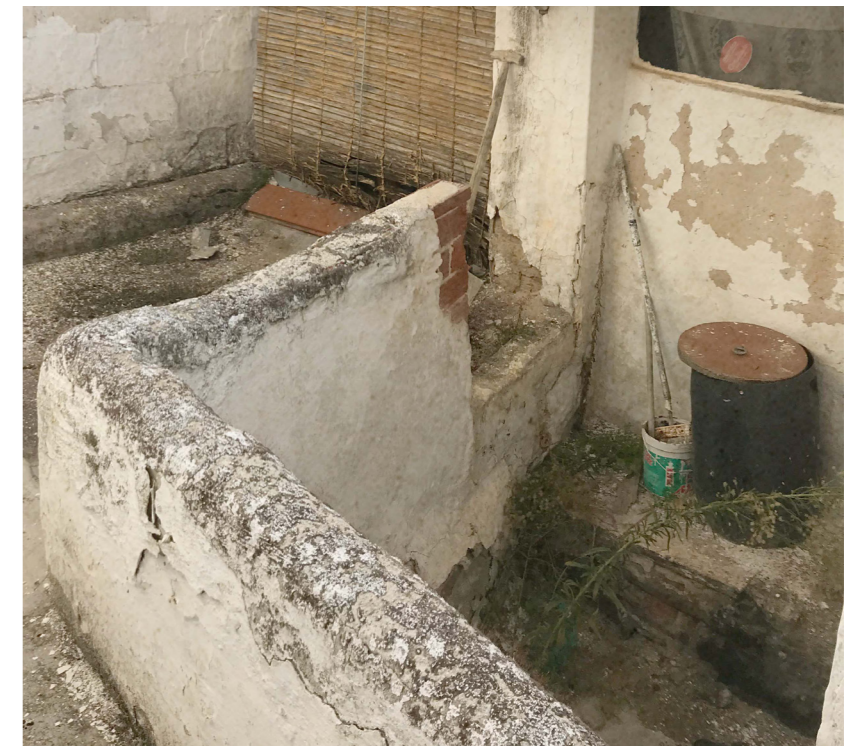
Figur 33. Mellan bostad och arbete finns entrén ned till silon.
