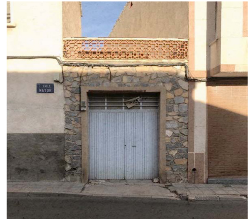
Figur 31. Fasad till den gamla tavernan, inklämd mellan byggnader. Stor port och perforerat tegelmönster i överkant.
