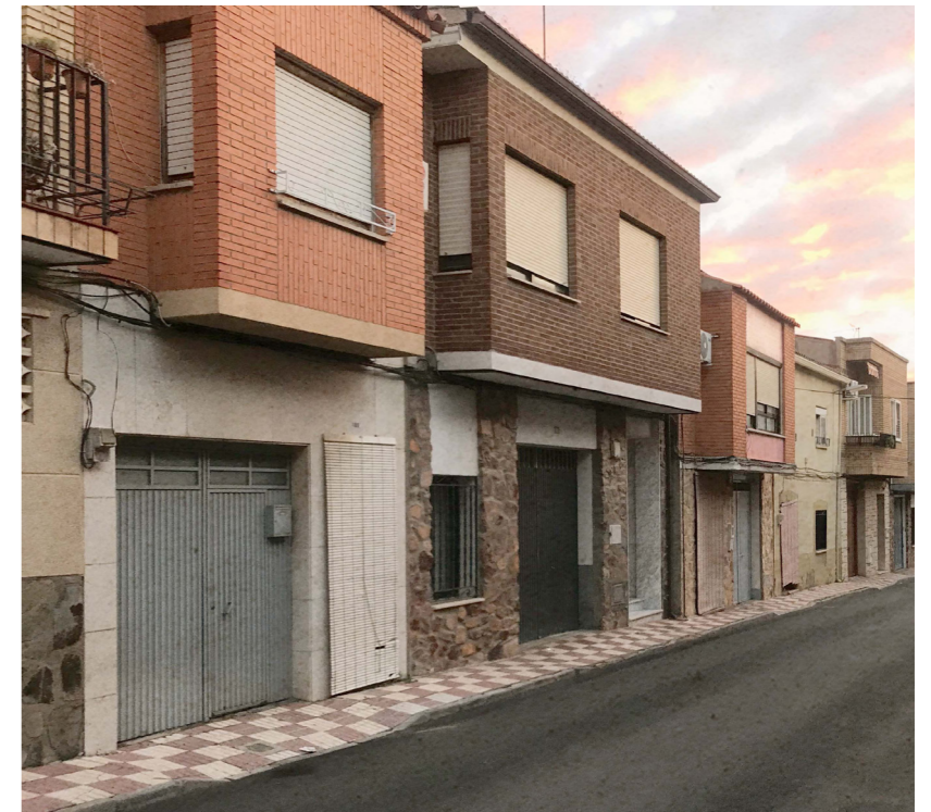
Figur 20. Tegel som det nya dominerande materialet.
