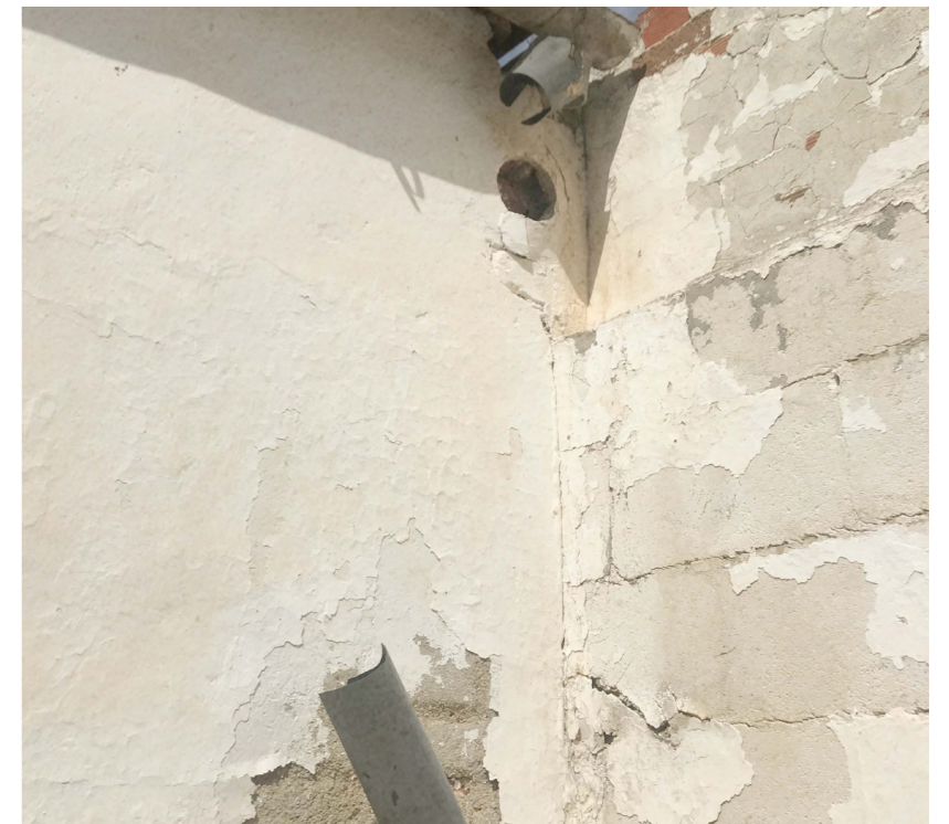
Figur 37. Uppsamling av regnvatten. Vattnet användes som dricksvatten.
