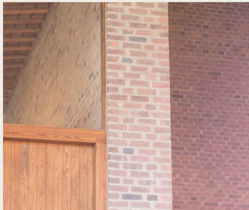
Samspelet mellan en dörrpost i trä och nätt kraftig vertikal vägg
