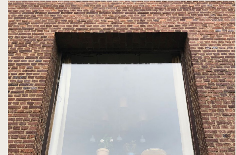
Det utsökta fönsterpartiet, och kök/arbetsrummet innan vid
