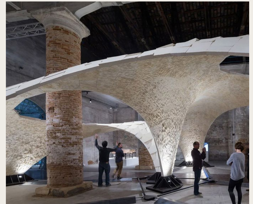
Sammankopplade block utan fästmedel så som lim
