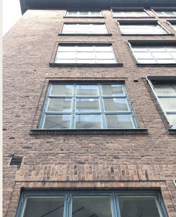
Fridkulla fabrikers AB, byggår 1931
