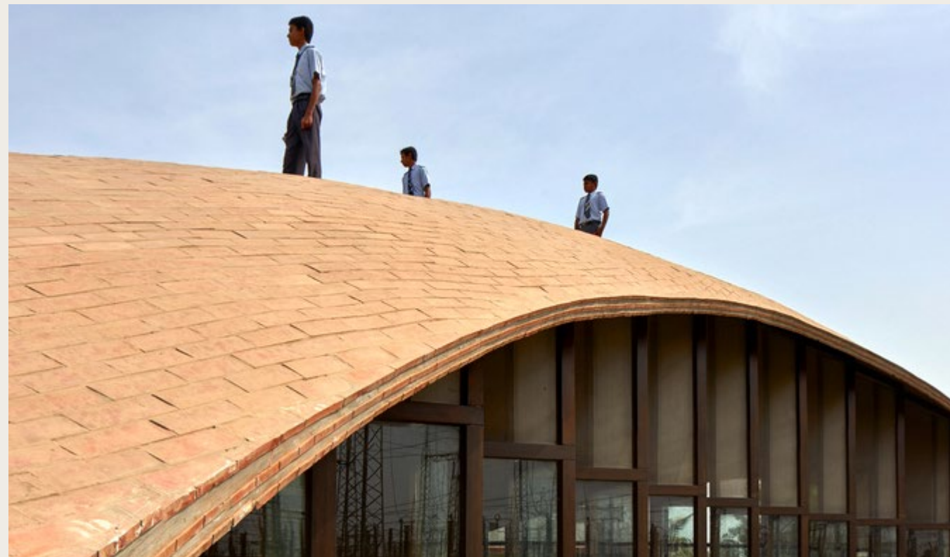
Fin detaljering i tegel, den kraftigt förstärkta katalanska valv tekniken kan ses i betongskiktet
