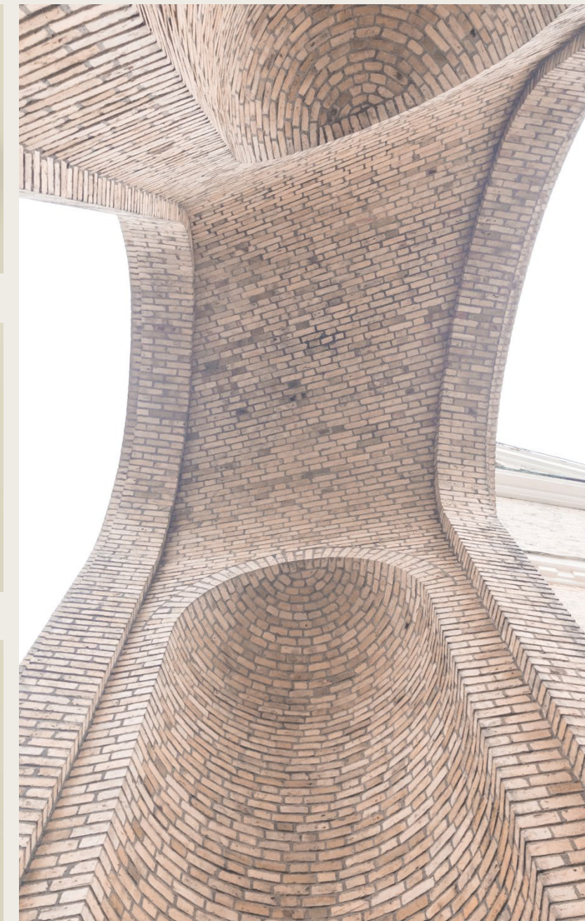
Ett av det vackrare elementen av tegel i området
