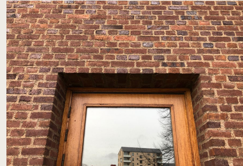
En utgång liggande i östlig riktning, tydlig skillnad i teglet syntes mellan det olika väderstrecken
