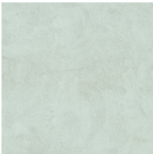
Återställ putsad fasad till ursprunglig kulör och karaktär.
