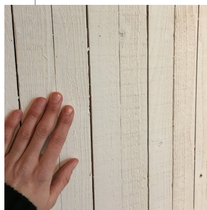
Träpanelen gör utställningsrummen flexibla då det är enkelt att spika, skruva och bygga om efter behov.
