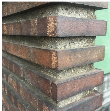
“Porten ramas in av ett vindskydd murat av hårdbrända smala tegelstenar. Porten har en trappa i natursten.”
