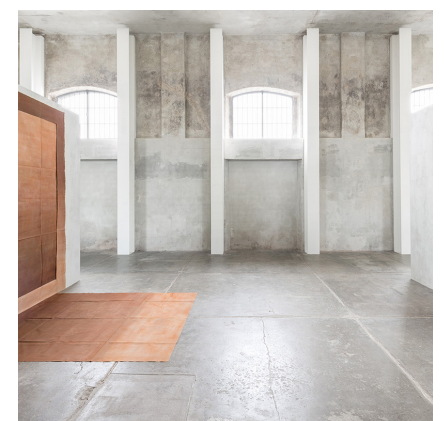
Galleri i den gamla fabriksdelen. Högt sittande fönster ger ljus utan att ge insyn eller utblick.
