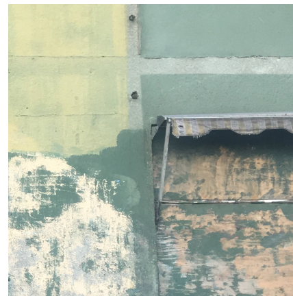
“Putsen var ursprungligen genomfärgad i en kulör. Ballasten i denna genomfärgade puts bestod av glimmer samt små brunröda stenar som skapade liv i fasaden.”
