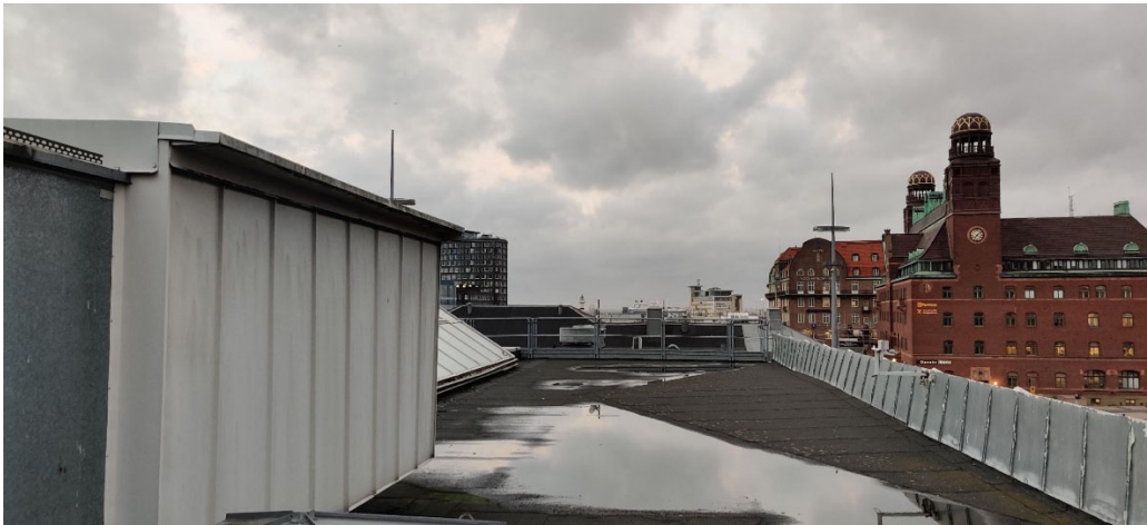
Figur 3.4 Taket på plan 4 i nordlig riktning. (Foto Elin Mattsson Hedenborg)
