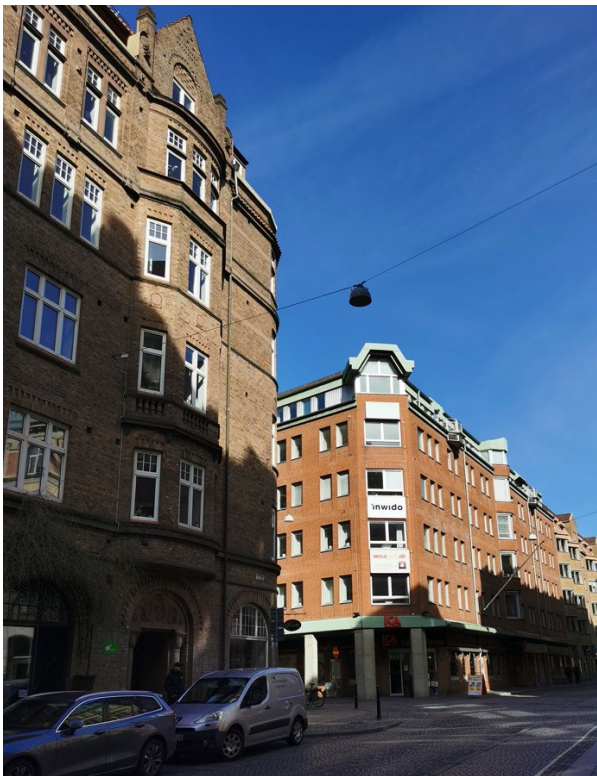
FIGUR 5.5 BYGGNADER PÅ ENGELBREKTSGATAN, FOTO TAGET AV SKEIME APRIL 2022
