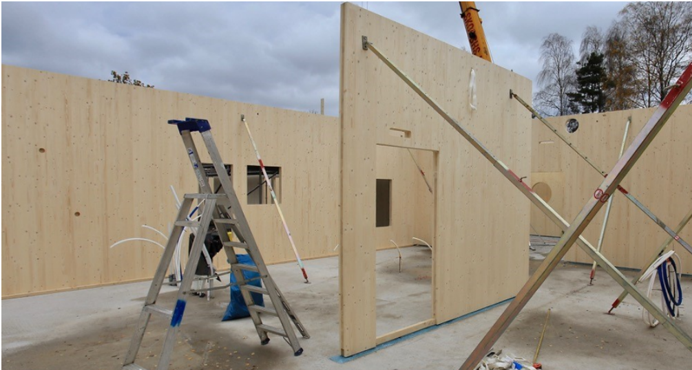
Figur 4.4 En bild i produktion på kritisk punkt, stående KL-vägg med ändträ mot bottenplatta från Fridh & Hells bygg AB.
