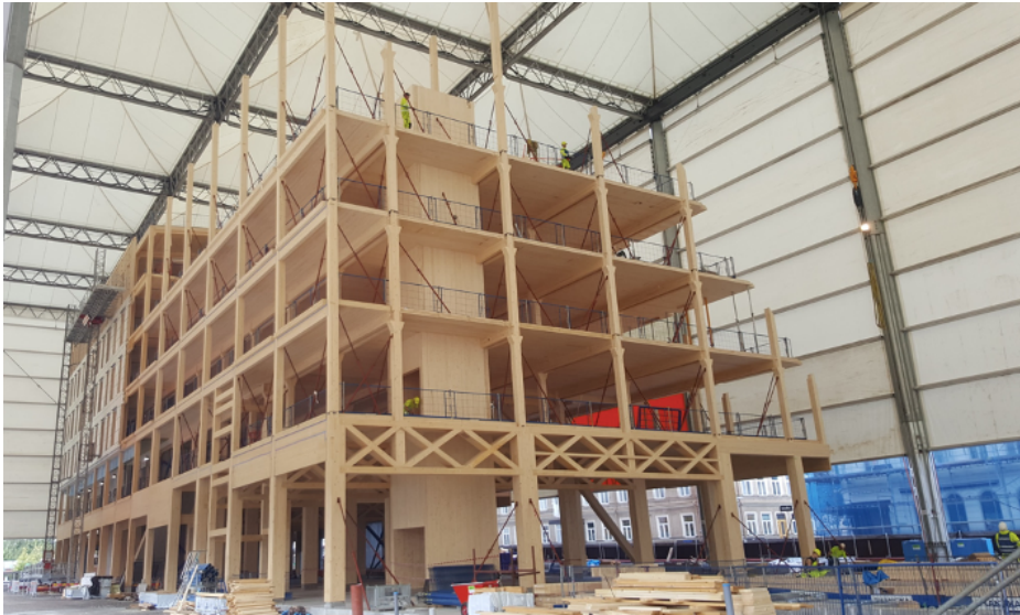
Figur 4.1 Bild från produktionen av Växjö kommunhus samt det heltäckande väderskyddet.
