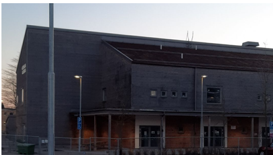
Figur 4.4 Färdigställd byggnad, förskola av Peab, byggd med träreglar.
