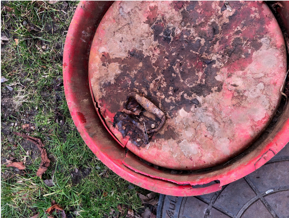
Figur 37: Trasigt innerlock till kammare
