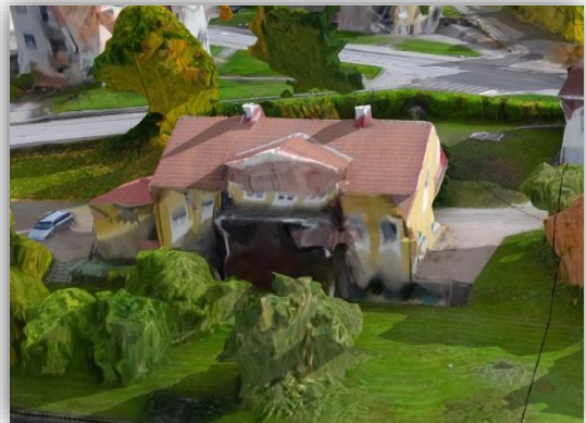
Figur 48 - Exempel på distorsioner i en fasad i lägre detaljerad meshmodell. foto Swescan
