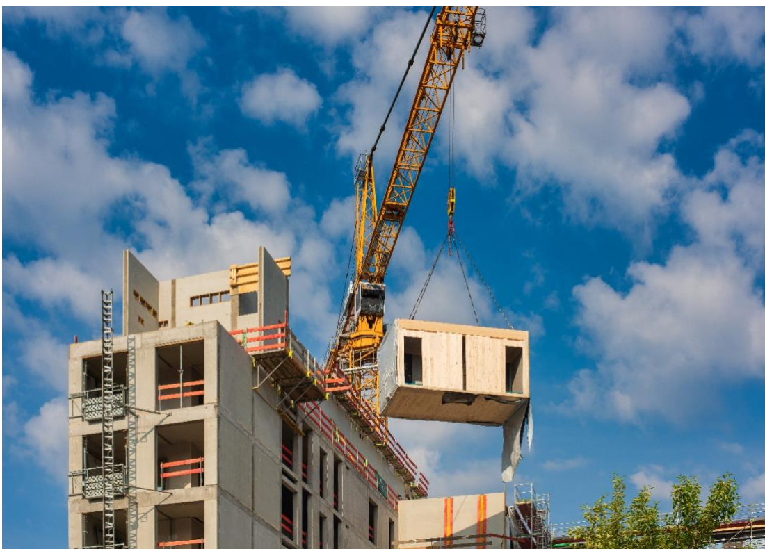
Figur 2.7, Bild över installation av Modulbyggnad, Shutterstock Inc, (u.å.)
