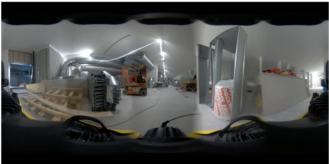
Figur 24: Intressepunkt 6 vid uppföljande skyddsronde, med 360-graderskamera.
