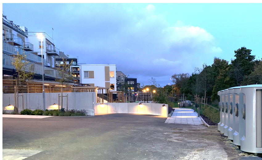
Figur 5. Bilden visar sopsugsinkastens placering samt avståndet mellan bostäderna och inkastpunkten på Brunnsnögsgatan i Brunnsnög (egen bild).
