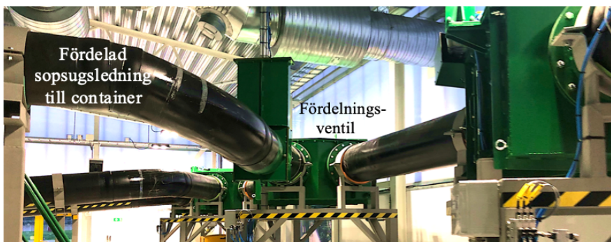
Figur 6. Bilden visar fördelningsventilerna i grönt som fördelar sopsugsledningarna i svart vars respektive avfallsfraktion fördelas in i rätta container i terminalbyggnaden i Brunnsberg (egen bild).
