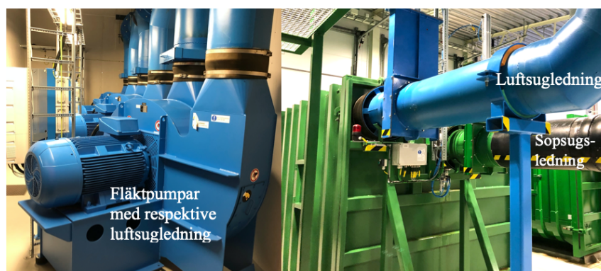
Figur 7. Bilden till vänster visar de tre fläktpumparna i fläktrummet med respektive luftsugledning i blått som leds vidare i terminalbyggnaden (egen bild). Till höger visas en container i grönt för plastavfall i terminalbyggnaden med sopsugsledningen i svart samt luftsugledningen i blått från fläktpumparna
