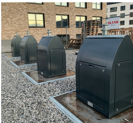
Figur 9. Underjordiska behållare på Systemeraregatan 8 i Brunnshög (egen bild).
