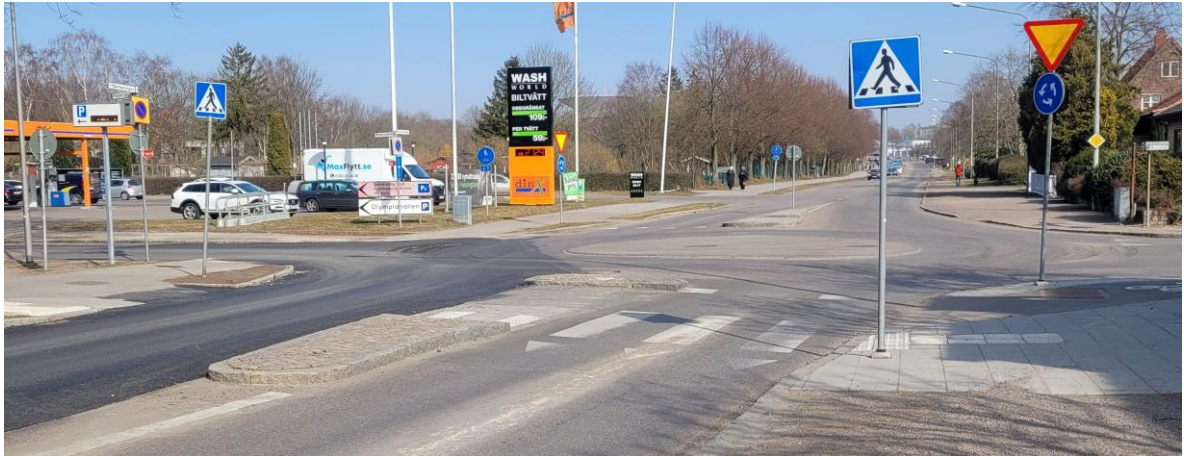
Figur 31: Egentagen bild som visar Filbornavägen – Jönköpingsgatan efter utförda åtgärder 2019 (2022).
