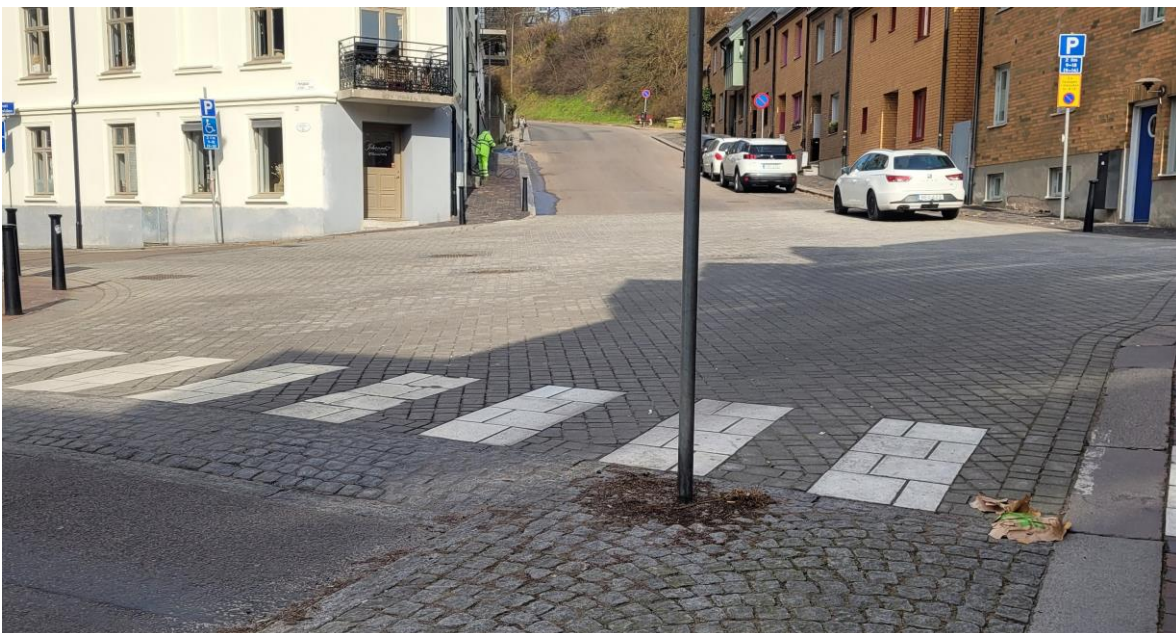
Figur 22: Egentagen bild som visar den upphöjda korsningen. I bilden syns även backen där fordon tenderade att hålla höga hastigheter (2022).
