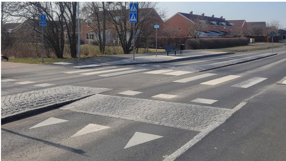
Figur 17: Egentagen bild som visar den upphöjda gång- och cykelöverfarten i förhållande till busshållplatsen (2022).
