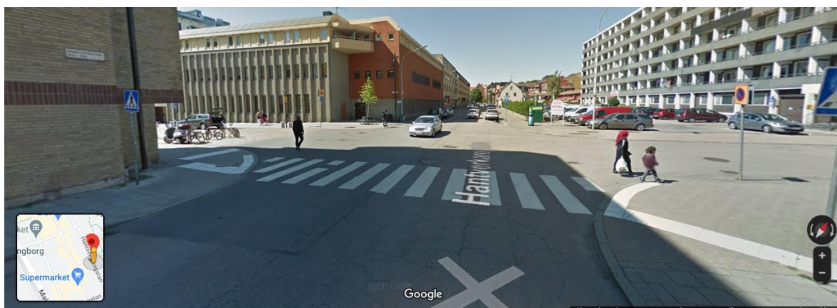
Figur 10: Korsningen Hantverkaregatan – Nedre Nytorgsgatan före ombyggnation (Google Maps 2017).
