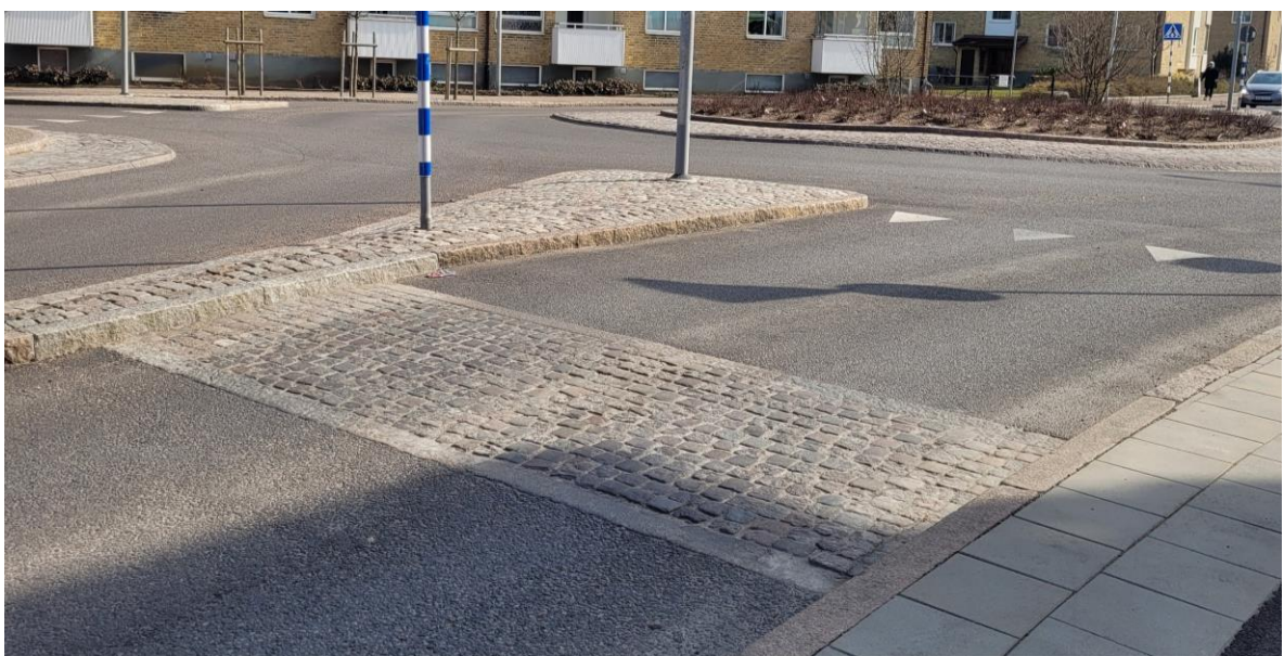
Figur 8: Egentagen bild som visar upphöjningen som en hastighetsdämpande åtgärd in i korsningen (2022).
