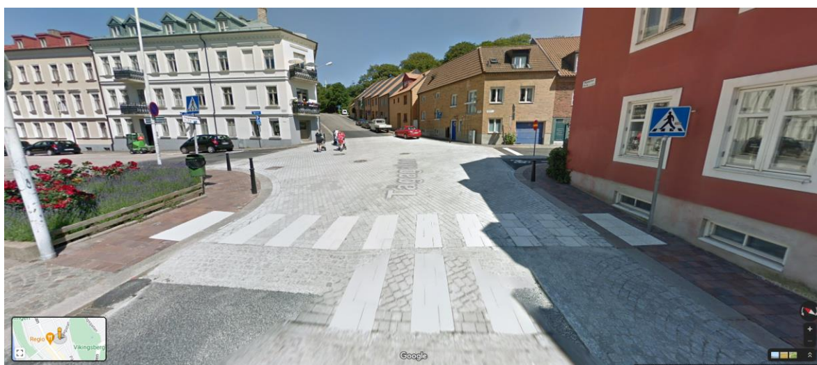
Figur 20: Tågagatan – Persgatan efter utförda åtgärder angivna ovan (Google Maps 2017).
