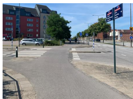
Figur 45. S-formation vid cykelöverfart på Lundavägen. (Egen bild).
