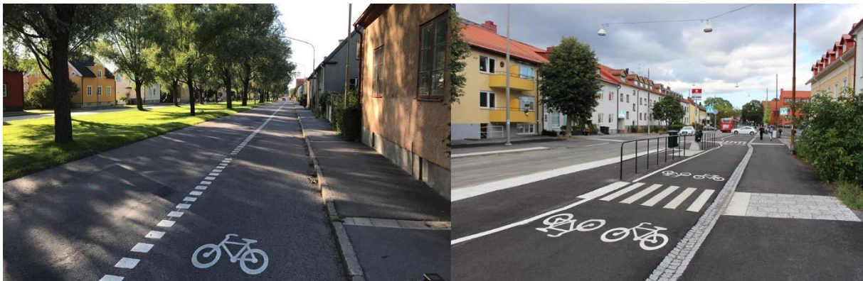
Figur 7. Cykelfält (t.v) separeras från biltrafiken med färgmarkering (Stockholms stad, 2022b). Cykelbana (t.h) separeras från biltrafiken med fysiska barriärer (Stockholms stad, 2022a).
