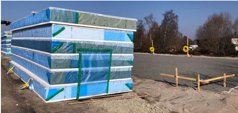
Figur 35 - Moduler av Trägrund 1 staplade (med emballage borttagen) inför montage.
