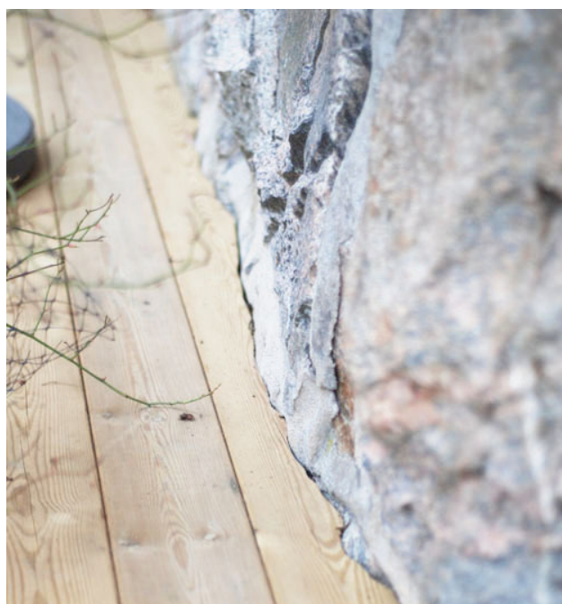
Fig 27. Trädäcket går ända emot berg och stenar. Runt träd lämnas det plats för att trädet ska kunna fortsätta växa utan att skada trädäcket. (Byggoteknik, u.å.)
