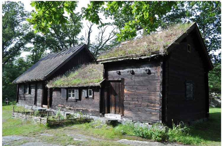
Fig 22. Blekingstugan i Vämöparken är en höglöftsstuga i klassiskt utförande med torvtak och timmrade väggar. (Boatbuilder, 2010)
