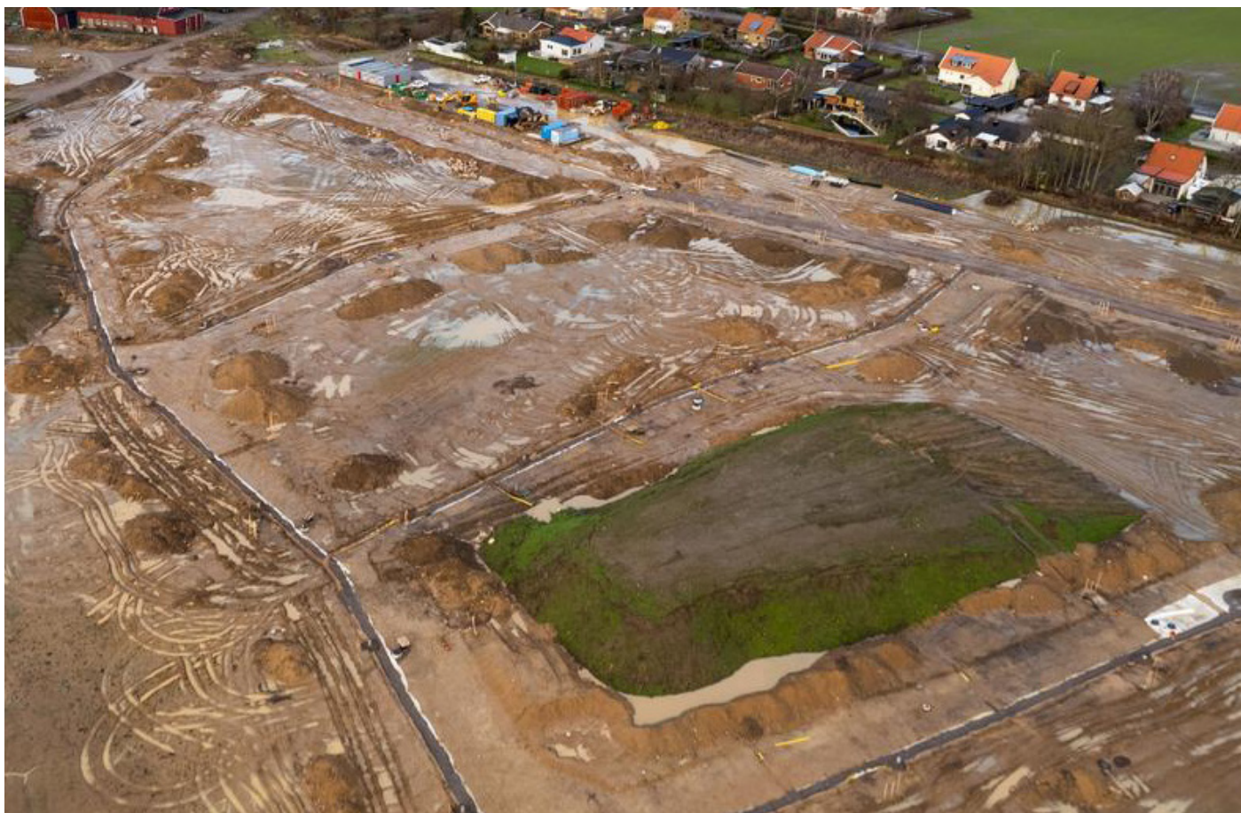
Fig 8. Flygbild över markberedd teräng. (Wall, 2022)
