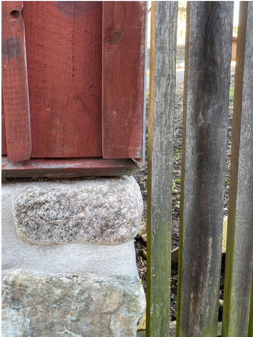
Bild 3: Den nätta anslutningen mellan fasad och grund får det att se ut som att träpartiet knappt rör vid stengrunden.
