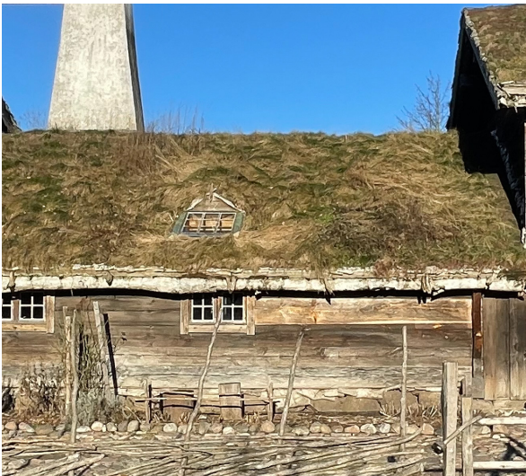
Ett takfönster på höglöftsstugan i Lund.
