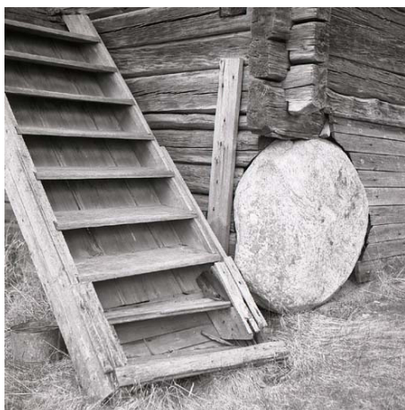
Fig 28. Stenar som behöver flyttas vid exempelvis vägkonstruktion i Aringsås används till Nymogens knutgrund. (Mickelsson, 1968)
