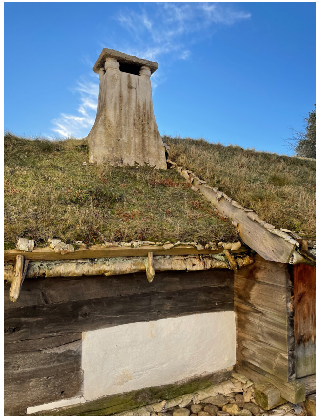
Bild 3: Huset har varierade takvinklar, byggmaterial och en synlig konstruktion.
