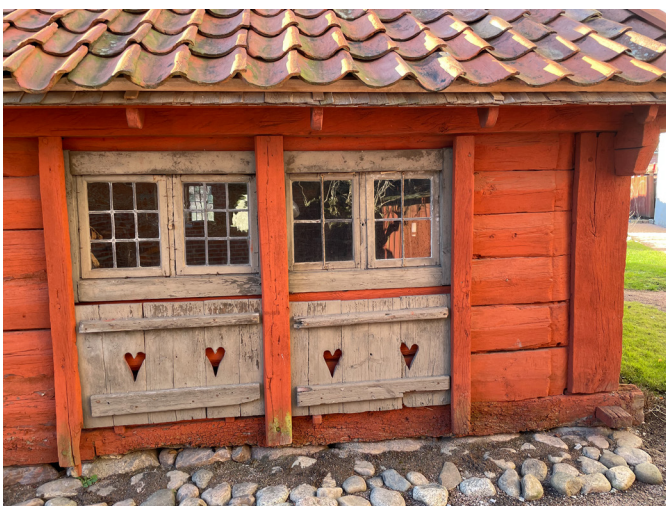
Bild 3: Olika fönster som markeras med pelare. Taket möter ytterväggen precis ovanför fönstret.
