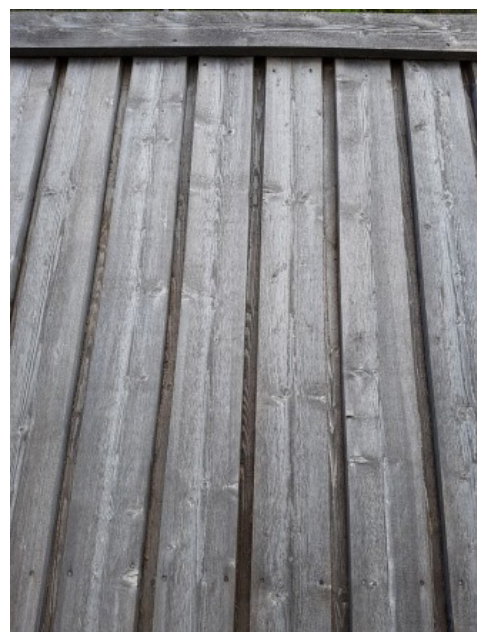
Fig 26. Byggnaderna täcks av faltak eller stickspån. Taket målas i samma färg som fasaden. (Sundsvalls byggnadsvård, 2018)
