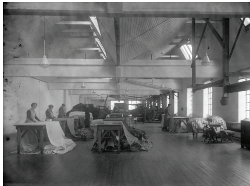
Bild 2. Stämningbild av tidig verksamhet.
