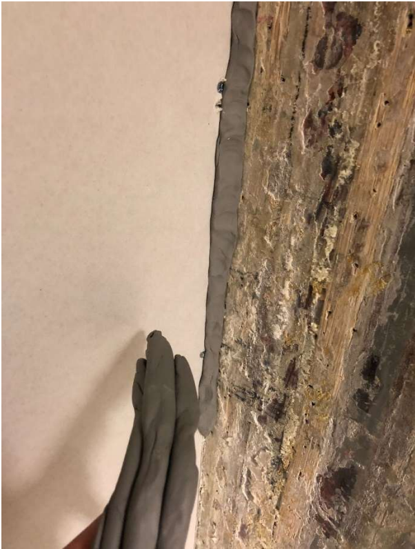
Figur 3.3 Tätningsslera längs mötet mellan testvägg och befintlig betongvägg.
