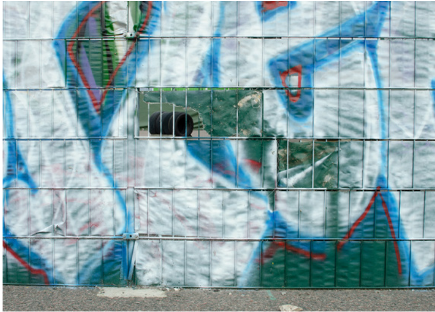
Figur 80: Gjerdet etter reparasjonene.
