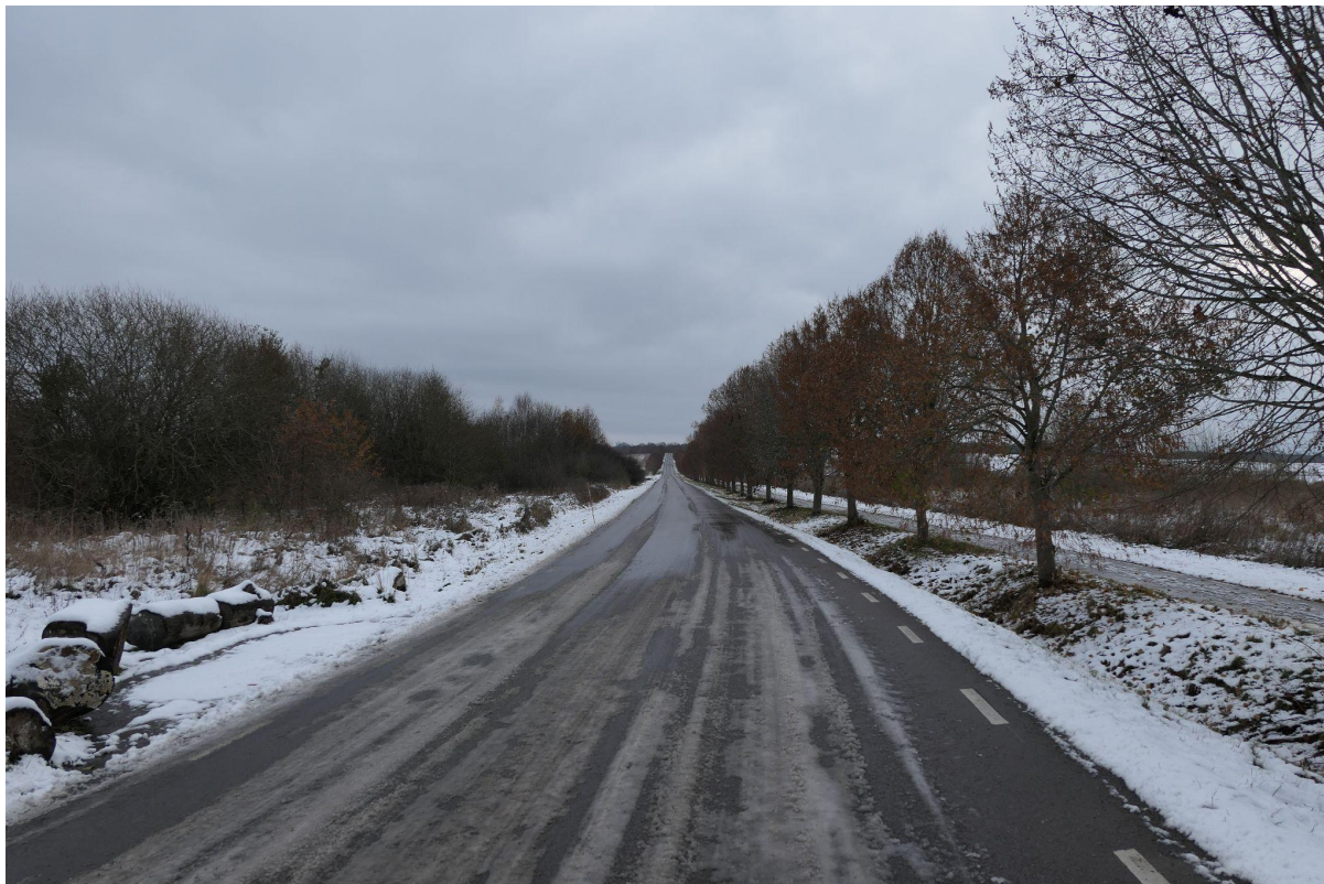
Fig. 20. Torupsvägen mot Torup, tagen från norr. Fotografi: Agnes Jakobsson 2022.
