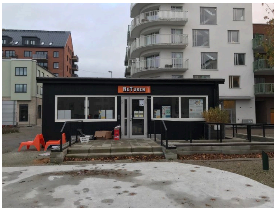
Figur 5: Returen Spårvägen, obemannad återbrukscentral (Asp 2022).
