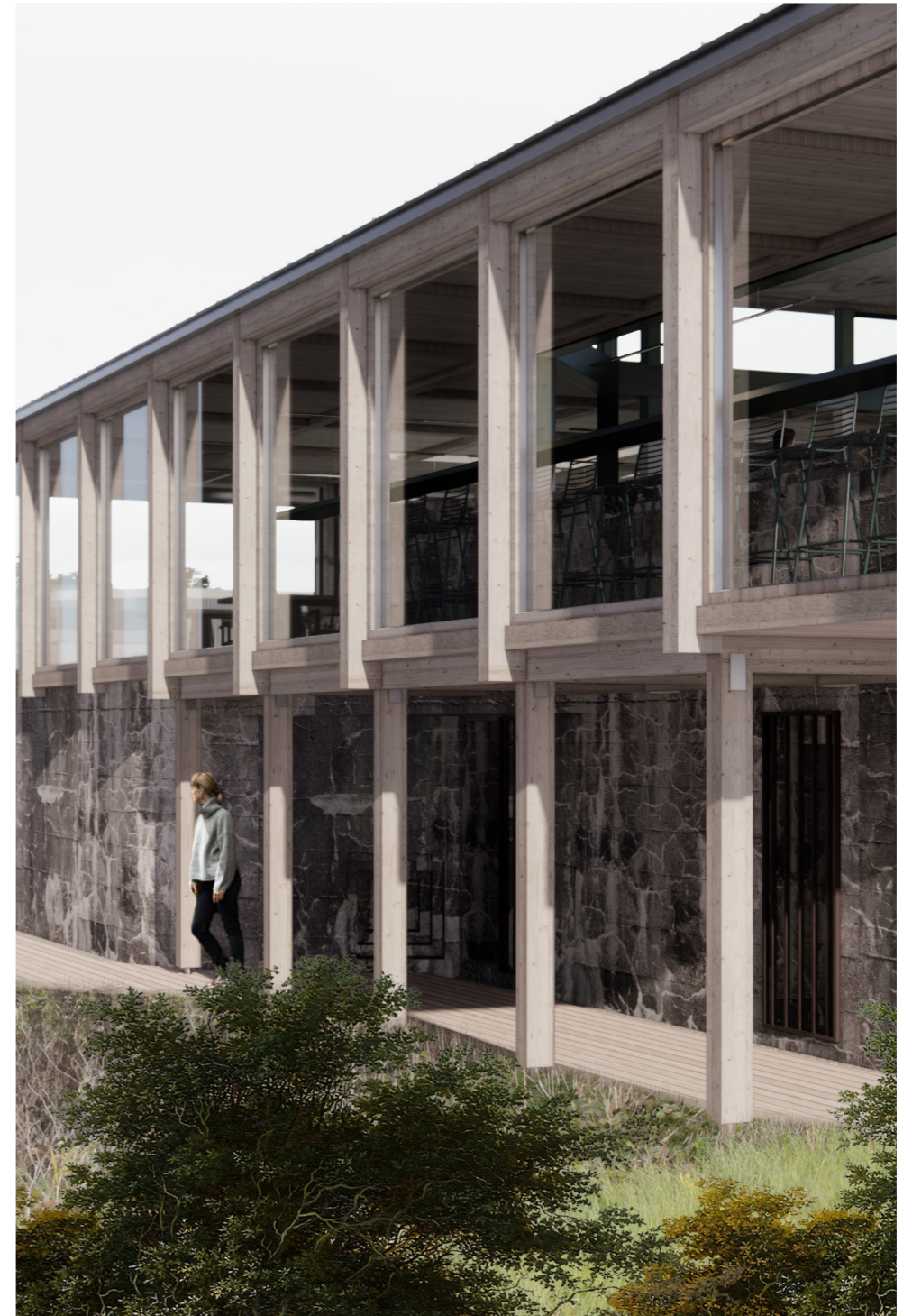
Restaurangens fasad med bunker som fundament. Träpelare håller upp fönsterpartier och ett tak klätt i pannplåt.
