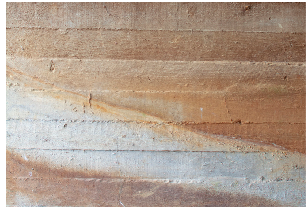
I väggarna syns det trämönster som formats av träformen från uppbyggnaden av bunkern. Fotografi: Eget
