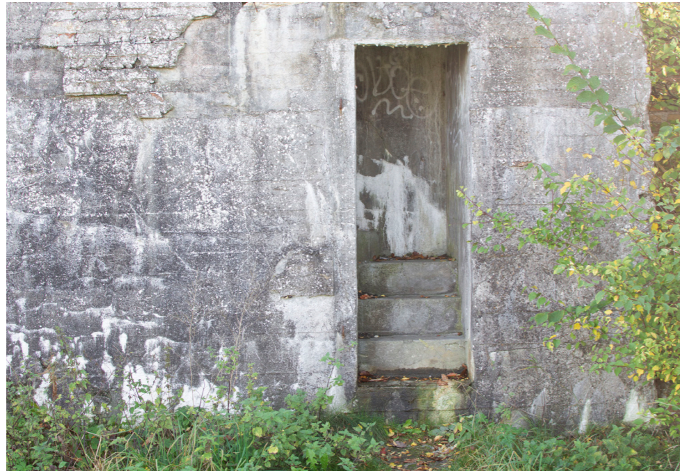
Fotografiet visar Regelbau L413A norra fasad med ingång till observationspost. Fotografi: Eget
