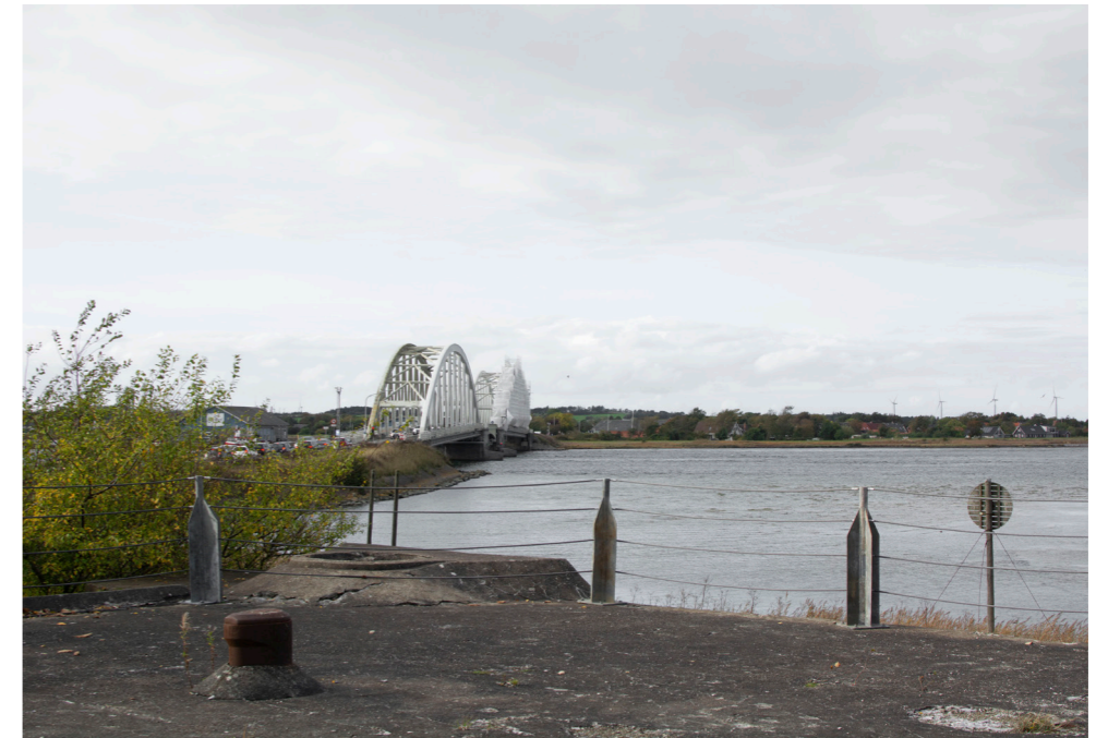
Utsikt mot norr från taket på Regelbau L413A. Fotografi: Eget
