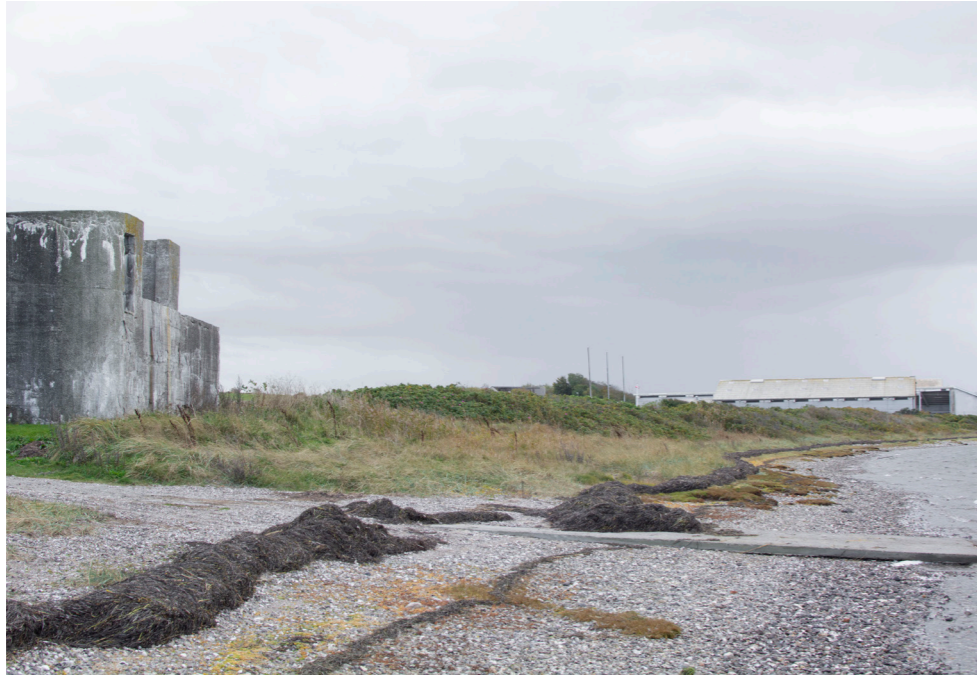
Ramp ner mot vattnet. Fotografi: Eget
