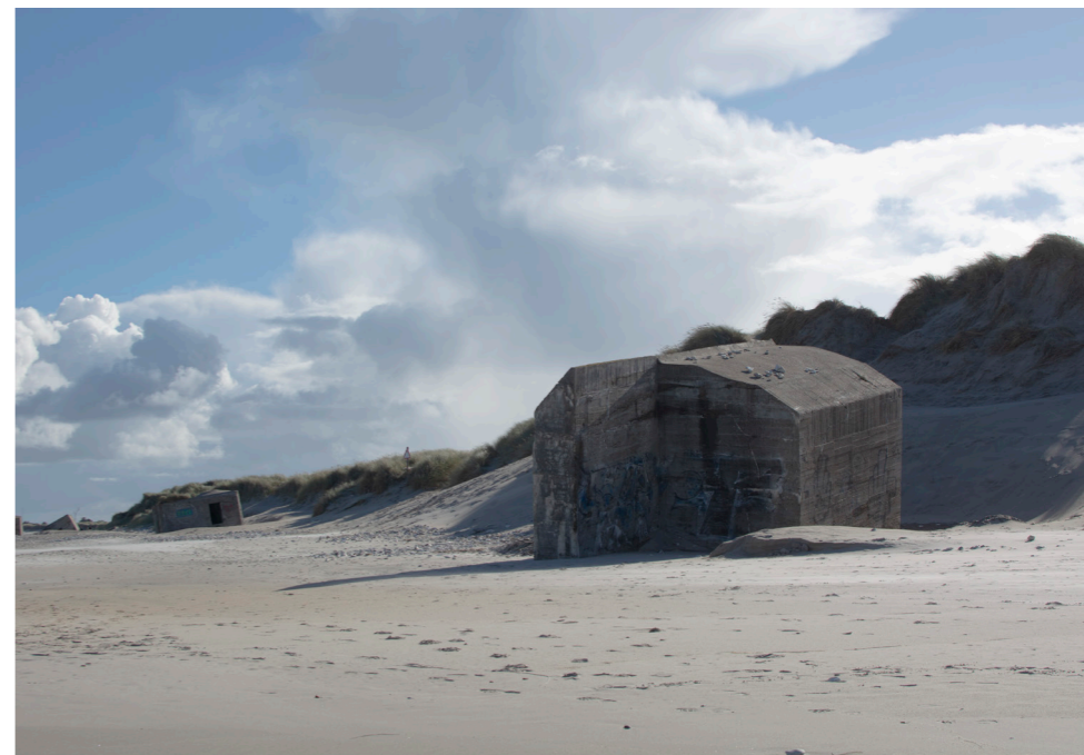
1. Delar av Regelbaubunker och maskingevärsbunker. Fotografi: Eget
