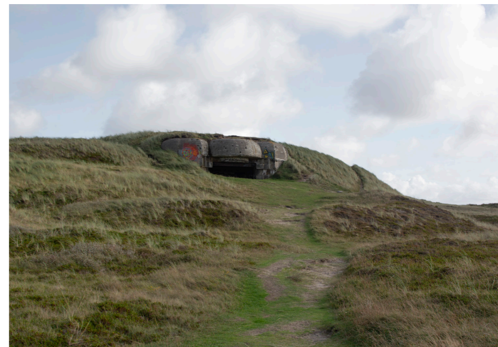
2. Bunkerns runda hörn hjälper bunkern att kamoufleras sig i naturen. Fotografi: Eget
