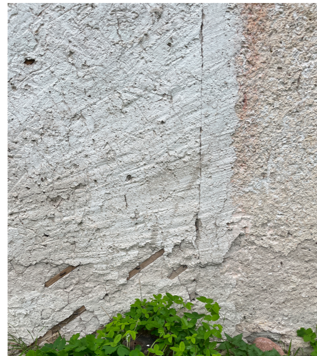
Fasad och takmaterial från tomten: Träpanel, Kalkputs och plåttak.
