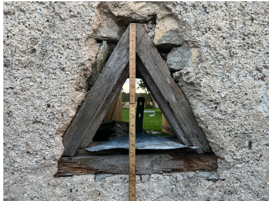
Uppmätning av fönster, Kalkstensladan.
