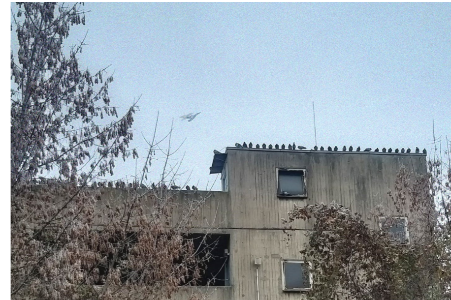
Det södra trapphuset som alltid är helt täckt av duvor.
