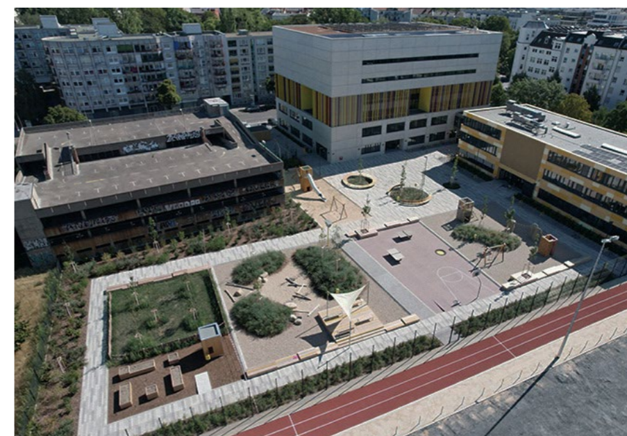
Parkeringshuset och skolans lekplats. Graffiti och den missfärgade betongen utgör en dystopisk backdrop till barnens lek.
