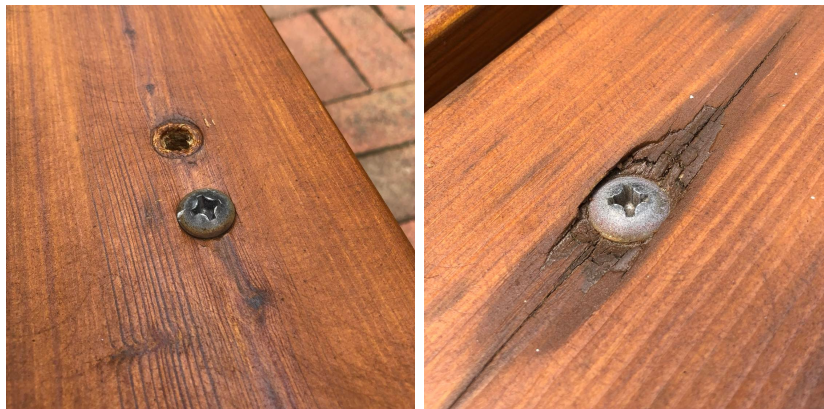
(a) Korrekt installerad skruv.
