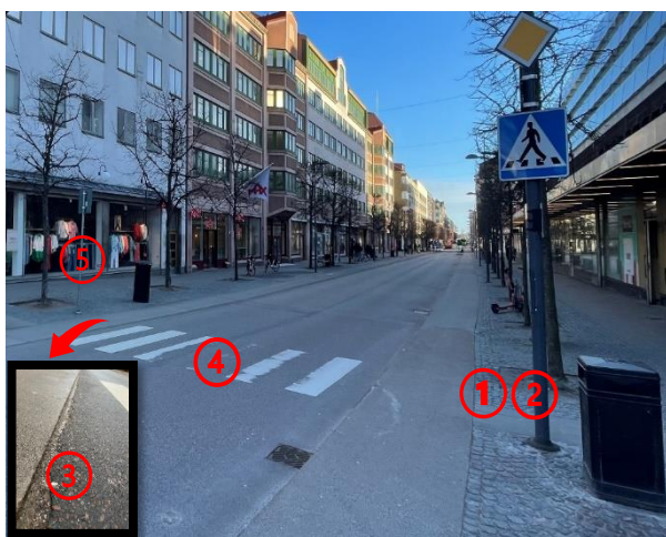
Figur 26: Visar utformningsbrister för det obevakade övergångsstället Södergatan 13.
