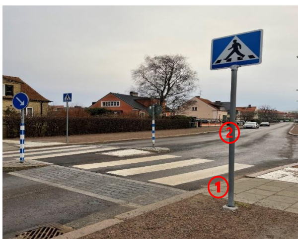
Figur 29: Visar utformningsbrister för det obevakade övergångsstället Tågagatan 66.
