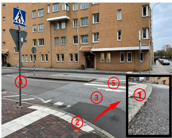
Figur 24: Visar utformningsbrister för det obevakade övergångsstället Furutorpsgatan 25.
