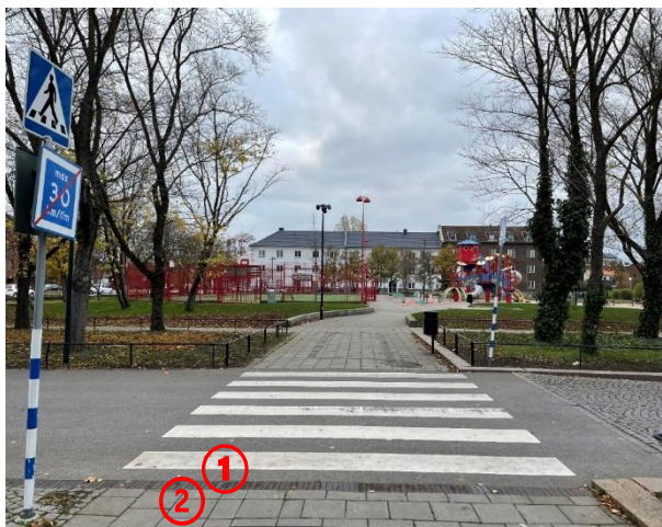
Figur 18: Visar utformningsbrister för det obevakade övergångsstället Wienergatan 11.
