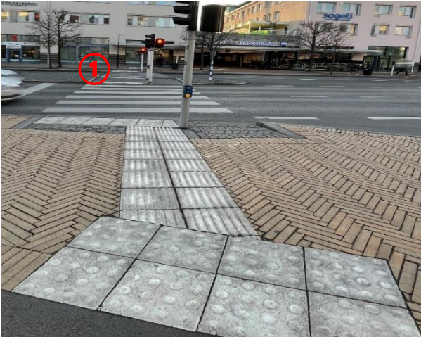
Figur 37: Visar en utformningsbrist för det bevakade övergångsstället Järnvägsgatan 21.
