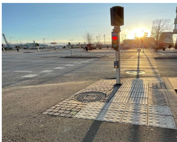
Figur 36: Visar en utformningsbrist för det bevakade övergångsstället Järnvägsgatan 29.
