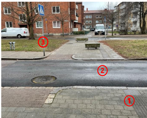
Figur 28: Visar utformningsbrister för det obevakade övergångsstället Norra Stenbocksgatan 34.
