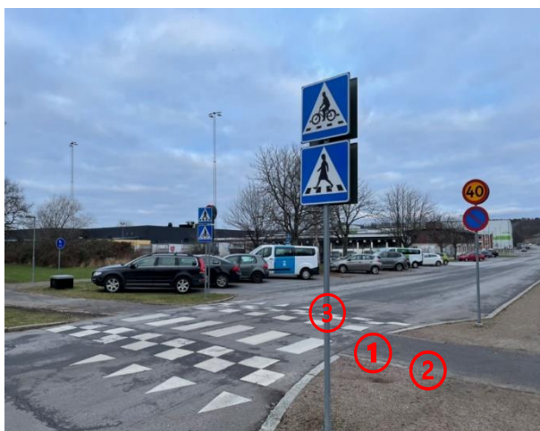
Figur 9: Visar utformningsbrister för det obevakade övergångsstället Elektrogatan 16.
