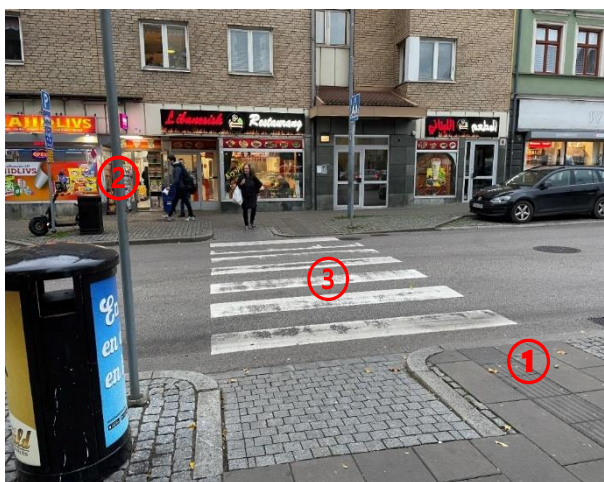
Figur 25: Visar utformningsbrister för det obevakade övergångsstället Carl Krooks gata 46.
