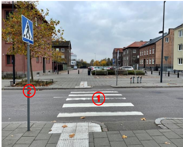
Figur 17: Visar utformningsbrister för det obebakade övergångsstället Industrigatan 20.
