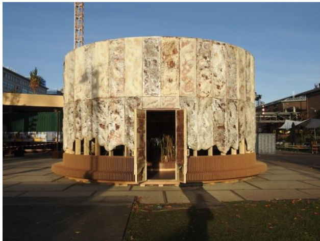
Figur 18: The Growing Pavilion är en cylinderformad byggnad av bl.a. mycelium (Återpubliceras med godkännande av Hannah Hagen, Company New Heroes 2023).
