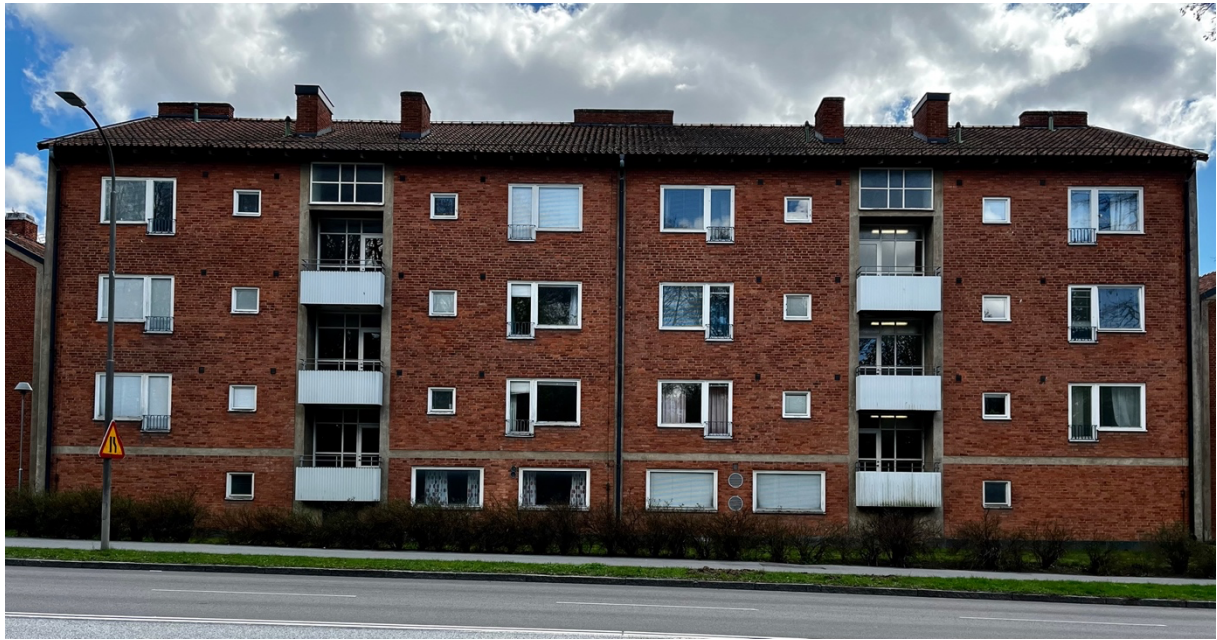
Figur 12 - Valt referensobjekt, Hus 2, Sjuksystem 2.
