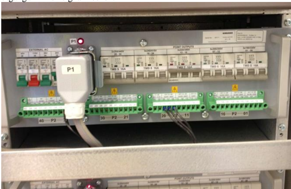
Figur 12, Kablarna som driver växeldrivsmotorerna där mätningar gjorts.
