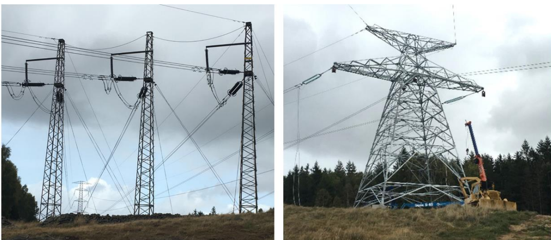
Figur 6. Till vänster en traditionell vinkelstolpe för mindre vinklar. Till höger en stubbe för större vinklar (Svenska kraftnät, 2021e).
