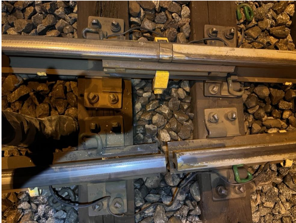
Figur 6 - Nödförband med tving (upptill) och öppen skarv (nedtill) (Foto från observationen)
