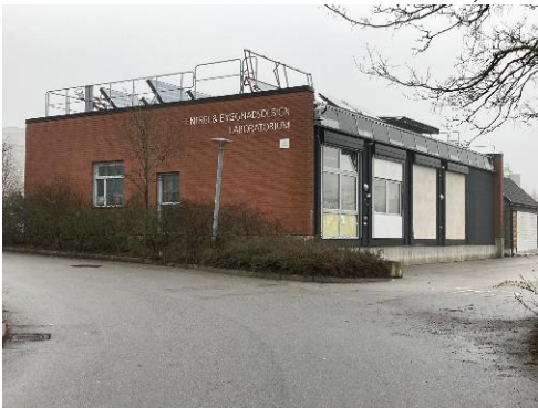
Figur 3.1 visar EBD-lab byggnaden med mätrummet på höger sida, andra närmast i bild med fönster mot syd.
