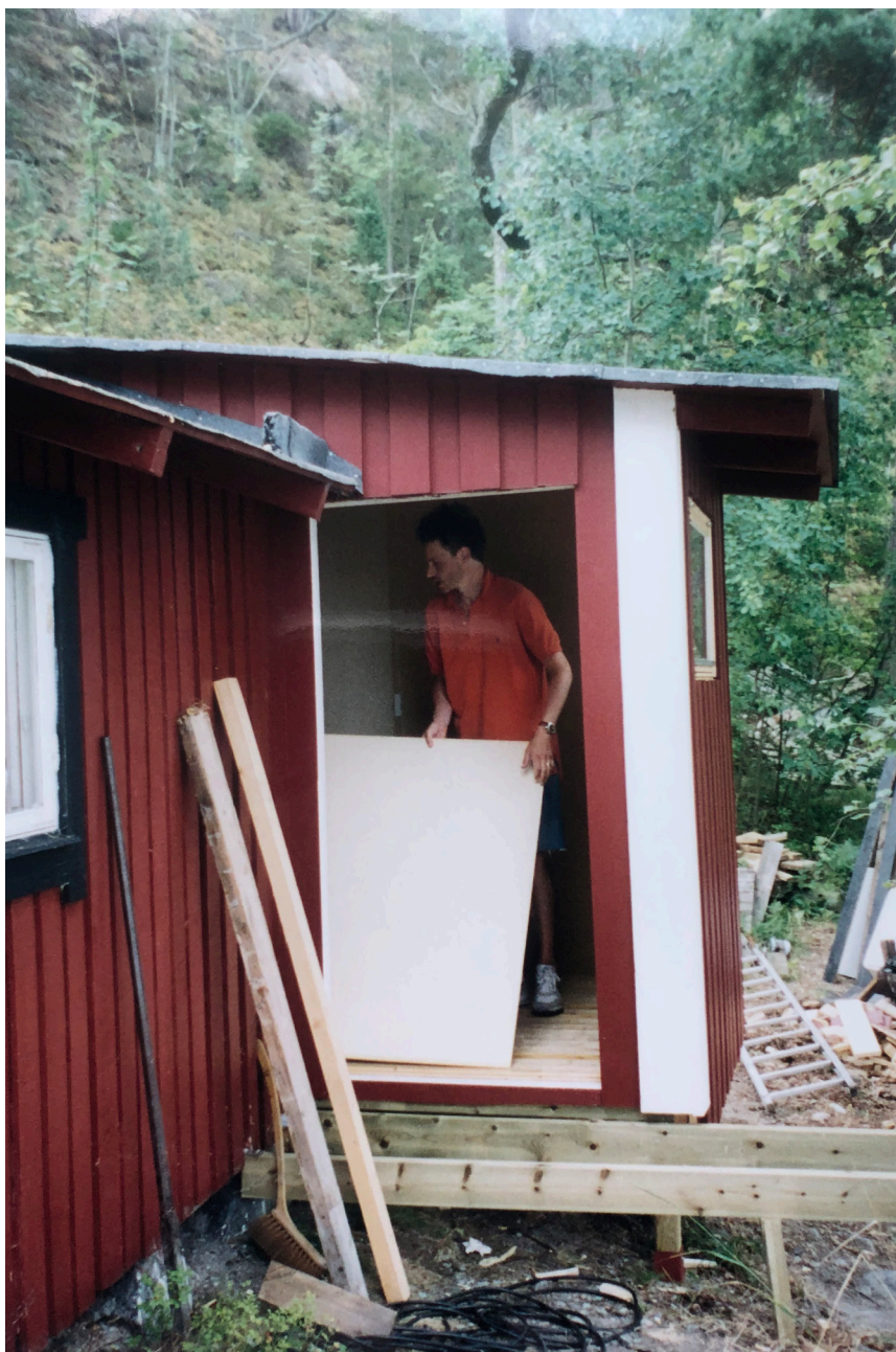
Figur 21: Min pappa hjälper till under bygget av Snickeboa.
