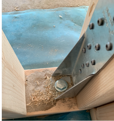
Figur 2.1: Vägginfästning i en tvåplansvilla.
