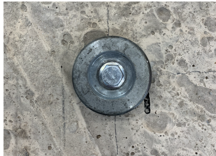
Figur 3.15: Monterad infästning genom bricka och platta.
