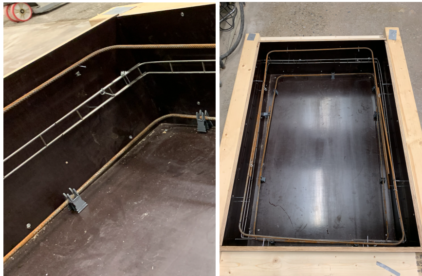
Figur 3.12: Armering av plattan innan gjutning.
