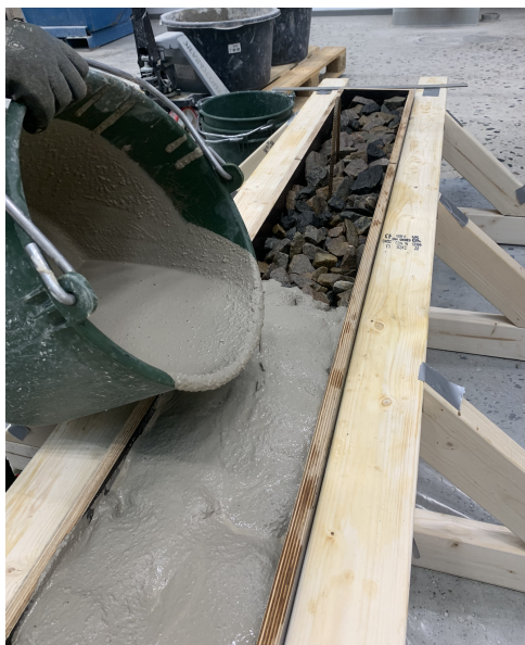
Figur 3.3: Efterinjektering av cementslurry.
