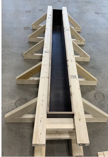
Figur 3.7: Balkfomrar storlek 2500 x 200 x 300 mm.
