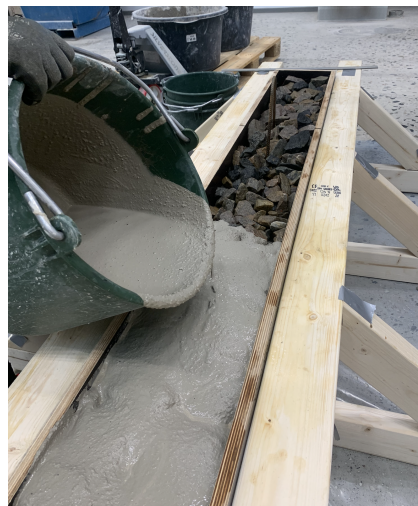
Figur 1: Tillverkning av balk av cementbunden makadam
