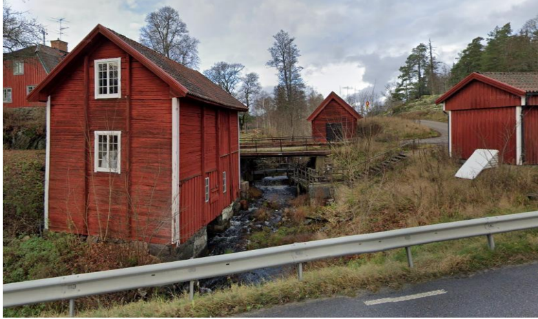
Figur 15. Skibordsdammen som servitutet avser.
