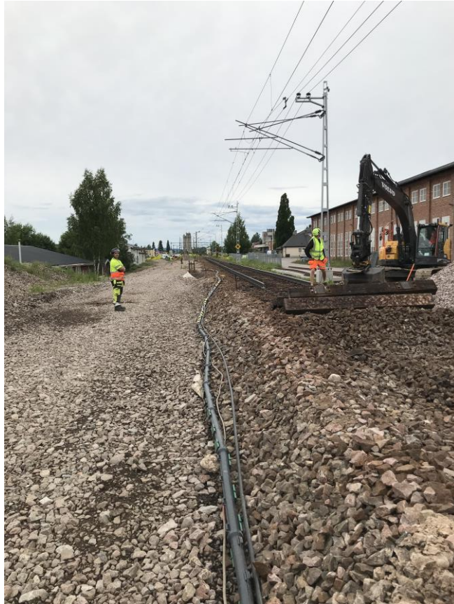
Figur 4, Kabelskydd i form av knäpprör (Foto: Peter Björklund, Trafikverket)
