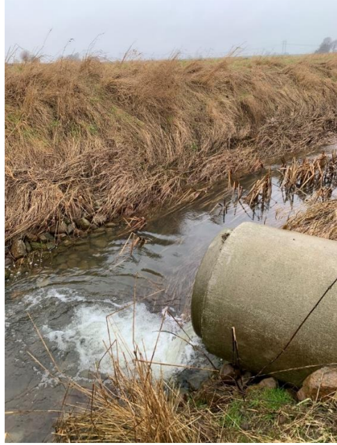
Figur 2a & 2b. Bild på störtbrunnen i dammen på Gårdstånga Nygård (till vänster) samt betongröret vid vilket utloppet från dammen till bäcken sker (till höger).
