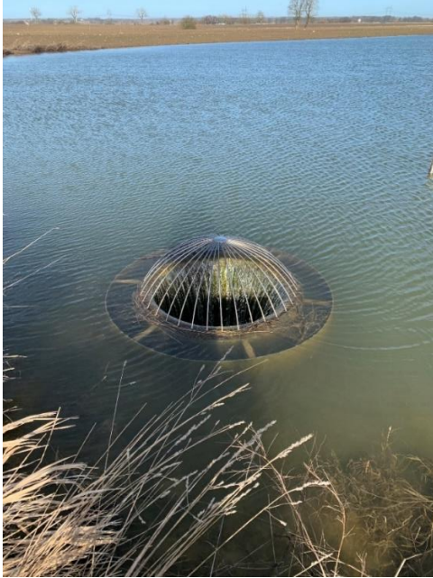
Figur 2a & 2b. Bild på störtbrunnen i dammen på Gårdstånga Nygård (till vänster) samt betongröret vid vilket utloppet från dammen till bäcken sker (till höger).
