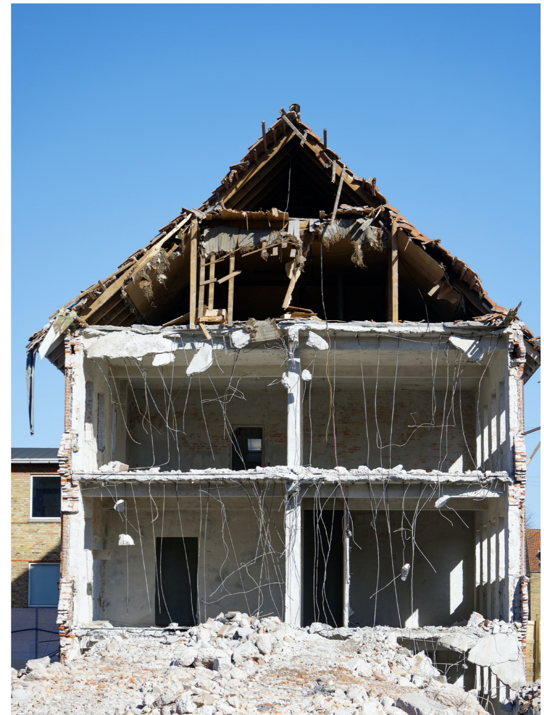
Figur 27. En byggnad i rivningsprocess (Larsen 2022).
