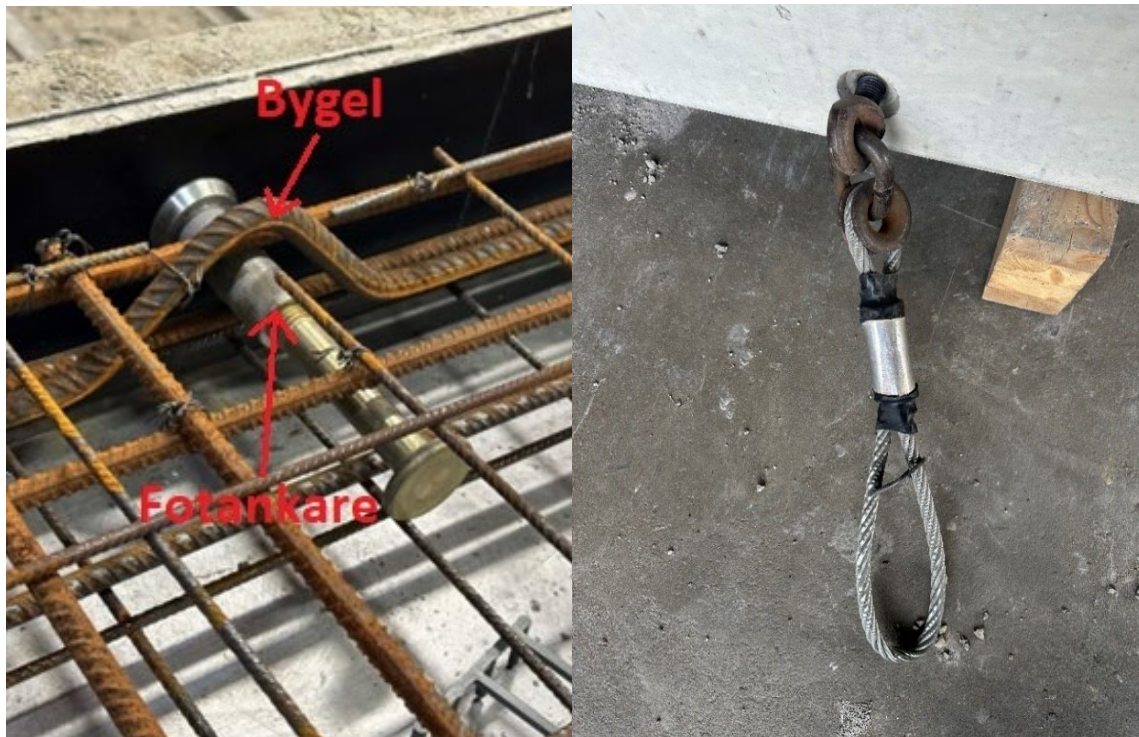
Figur 2. Transportlyft på oisolerad sida. På vänster sida visas ett fotankare med tillhörande bygel. Höger sida visar transportlyftet med tillhörande lyftdon påkopplat utifrån.
