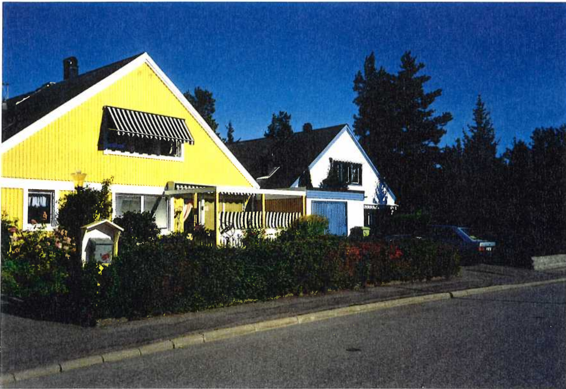
Nr 25 Husen är ihopbyggda med grannens garage. Vid ommålning har garage fått två färger.
