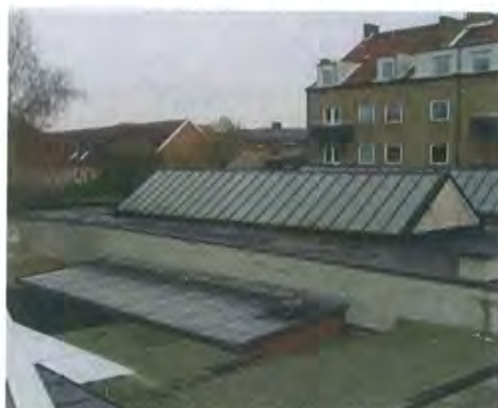
Bild 6. Neptuns innergård. Byggnaden med takfönster är garaget på Neptun 31.
