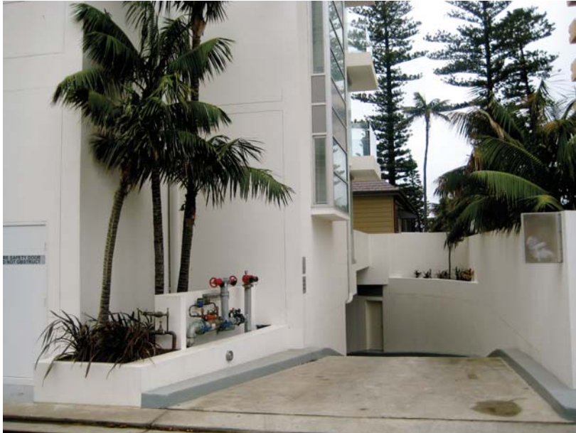
Figur 5. Rampen till parkeringsgaraget
