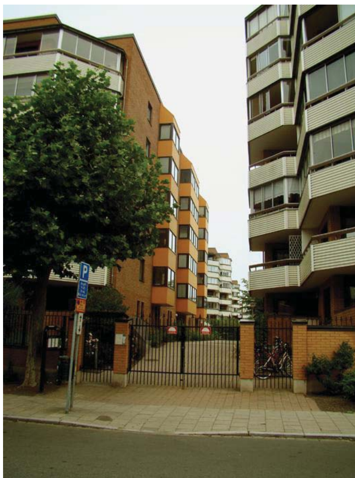
Figur 11 Foto taget söderifrån på Lugna gatan 11.
